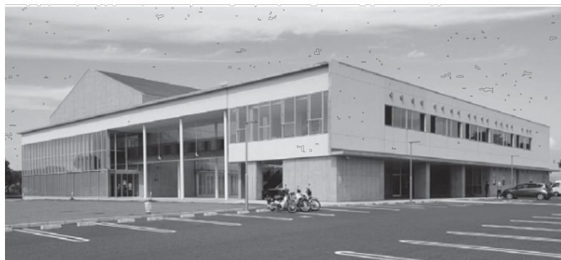
雨漏りの状況が改善してきている中央公民館
