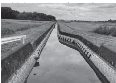
多々良沼側から工事が始まった逆川
