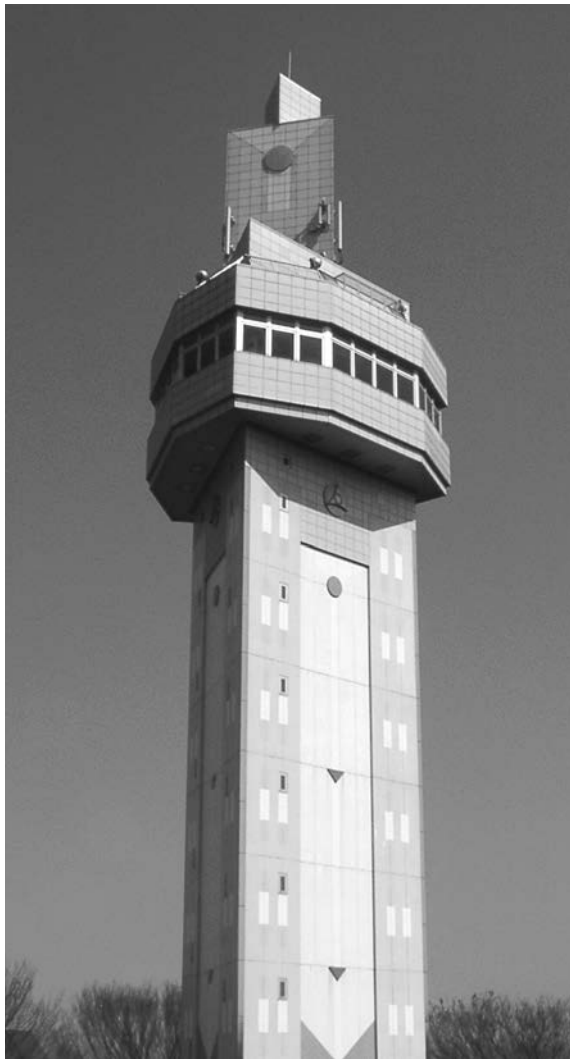
改修が予定されているシンボルタワー
