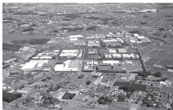
現在の鞍掛工業団地
