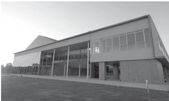
避難所の中心施設の一つ「中央公民館」
