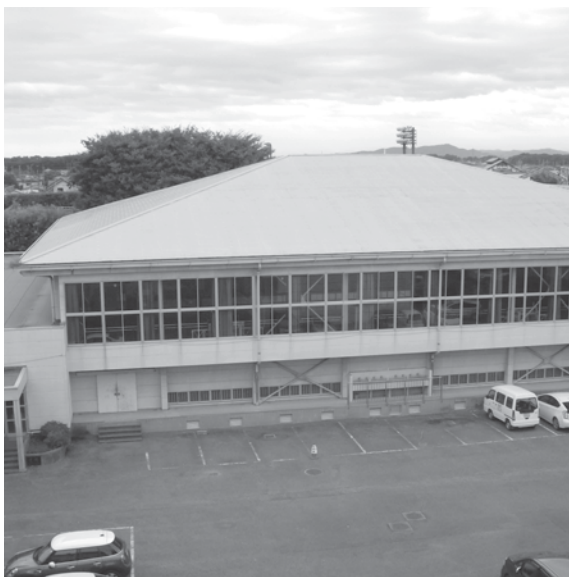
避難所としてエアコンの設置が望まれる体育館
