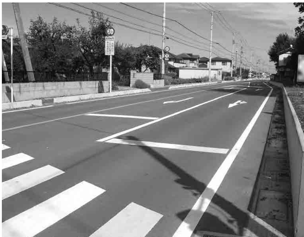
拡幅された町道幹線5号線
