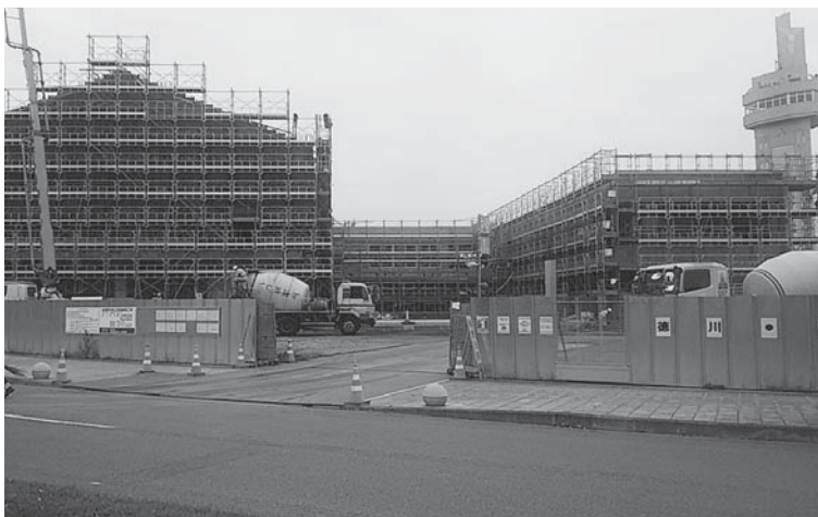
建設が進む中央公民館
