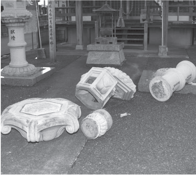
地震により倒壊した石燈籠（石打地内）
