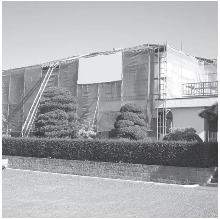
制度活用によるリフォーム中の住宅
