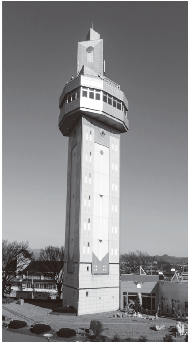
「羽ばたく町の象徴」 邑楽町シンボルタワー
