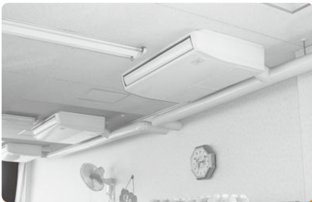
幼稚園・小中学校エアコン整備事業
