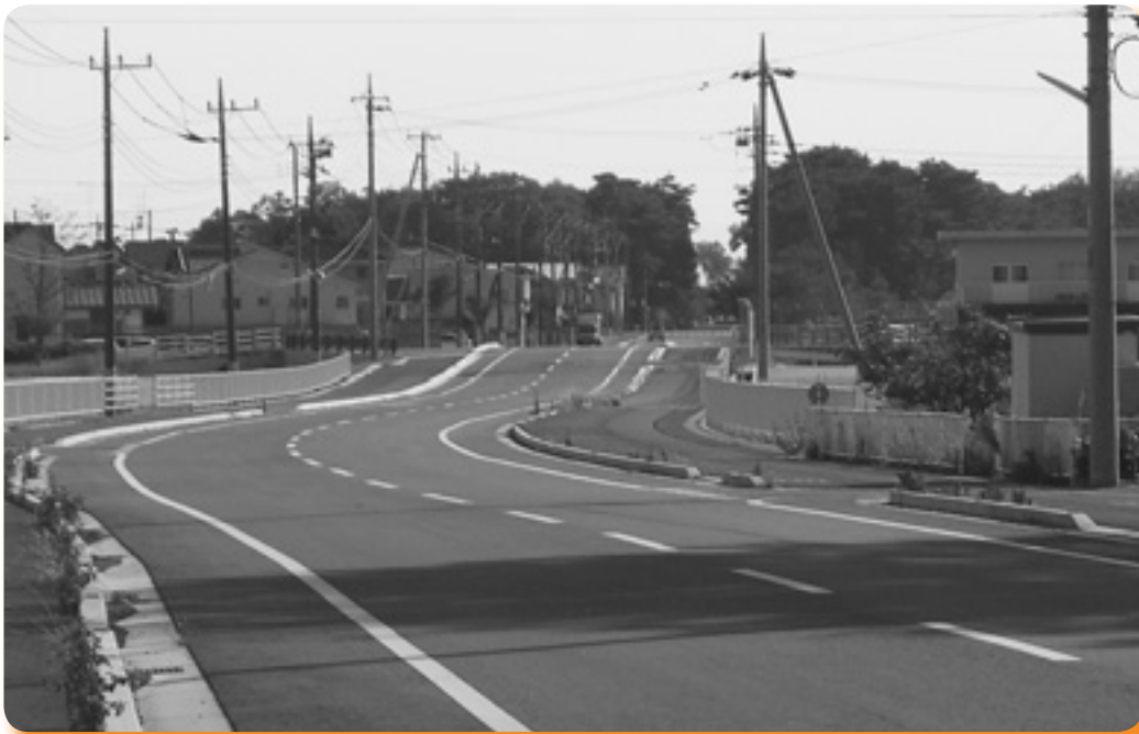
整備が進む町道幹線6号線
