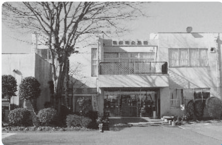
耐震診断中の邑楽町公民館
