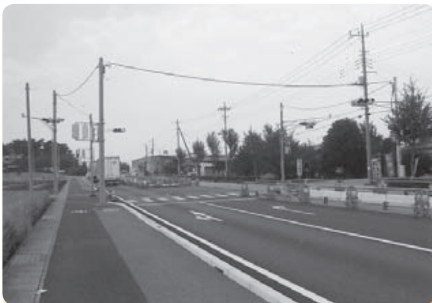
国道354号線に設置された信号機(狸塚地内)
