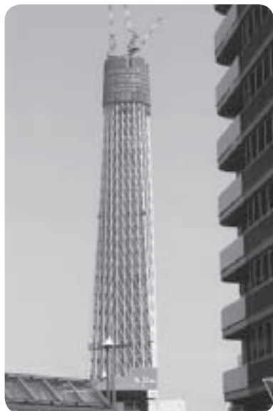
建設中の東京スカイツリー
