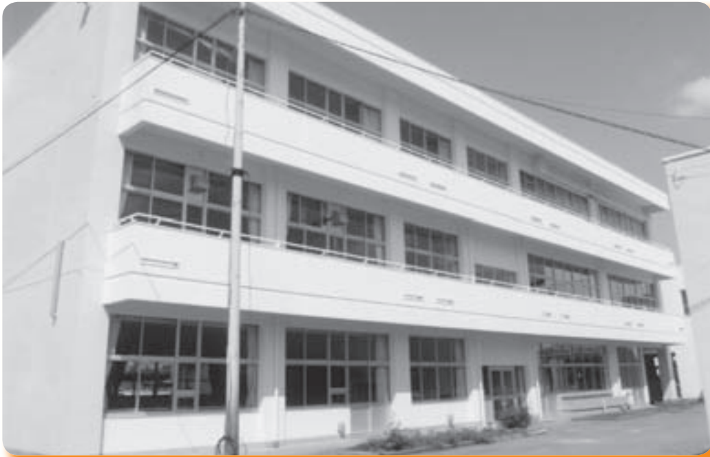
耐震補強・大規模改造工事が行われた中野小学校
