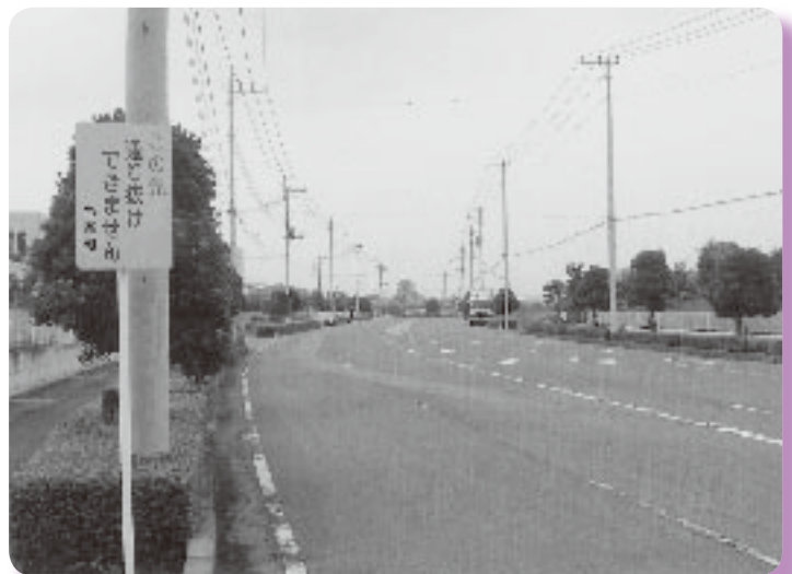
鞍掛第三工業団地内町道16-71号線
