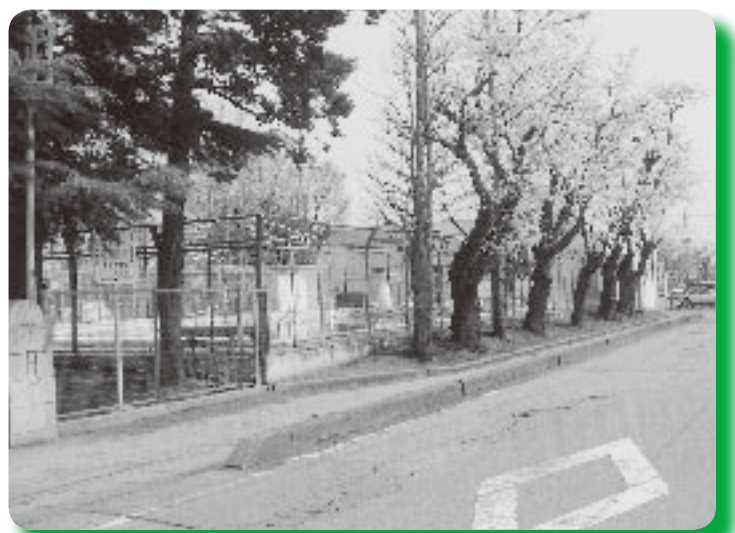
中野小学校プール
