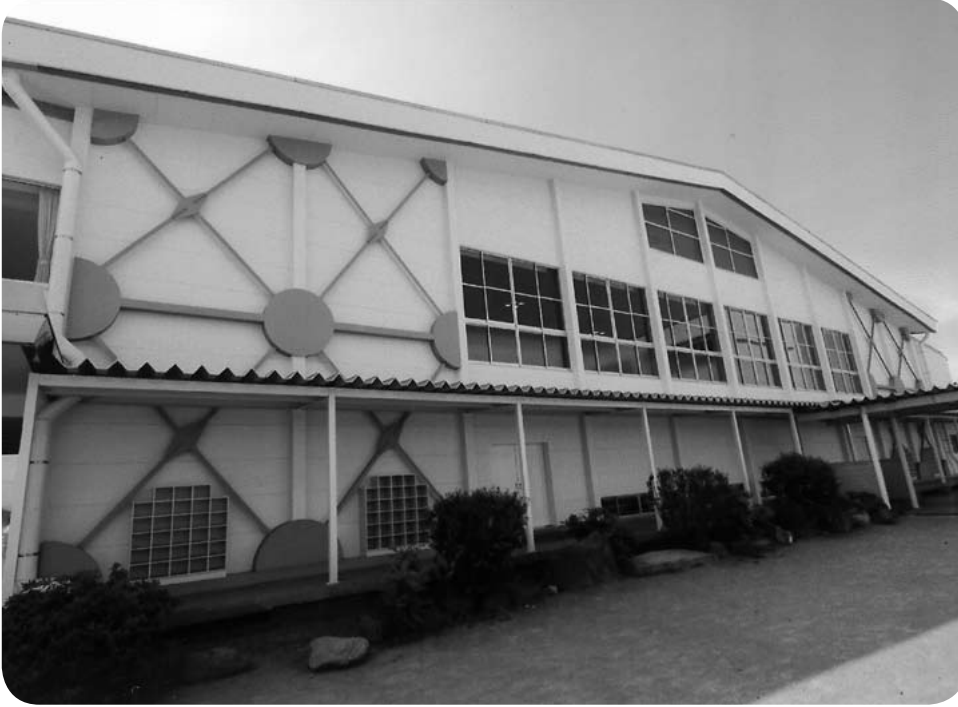
耐震補強等の工事が行われた邑楽中学校屋内運動場
