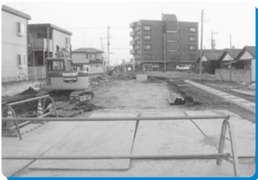
工事が進む鶉土地区画整理事業
