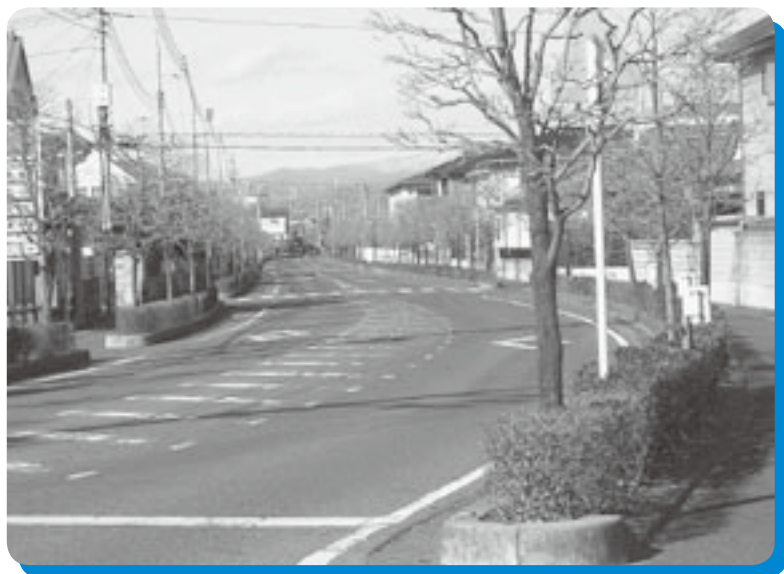
明野住宅団地内町道22号線
