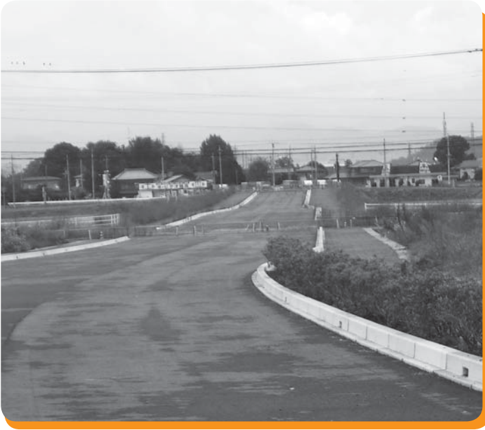
工事中の町道19号線
