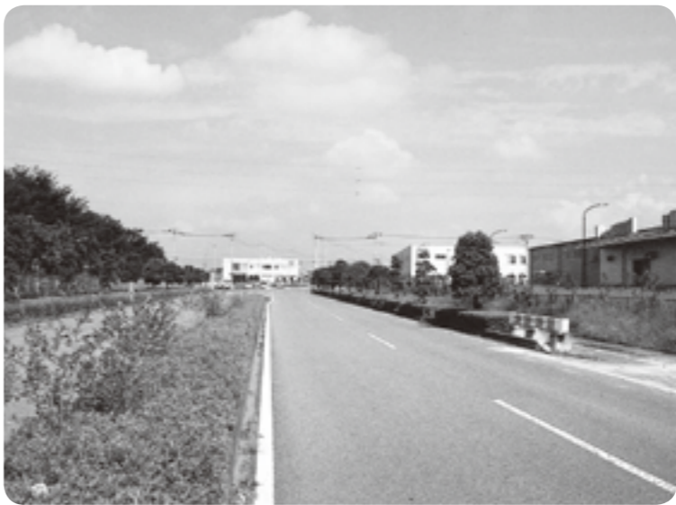
鞍掛第3工業団地
