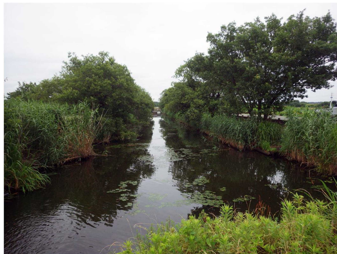
調査地の状況②(連結水路部：東方向を望む)
