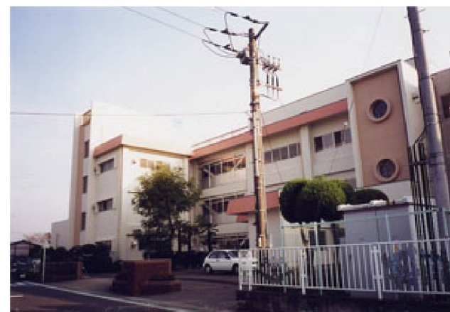
②東校舎北側外観 改修後
