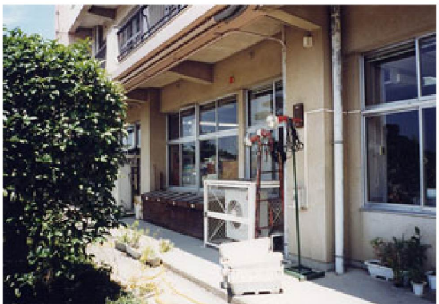
③1階北側 鉄骨ブレース設置前 外観
