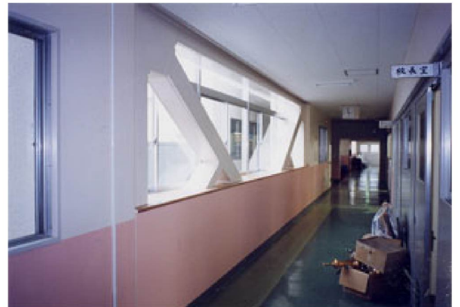
⑥1階廊下 改修後
