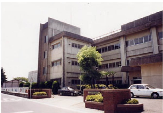
②東校舎北側外観 改修前
