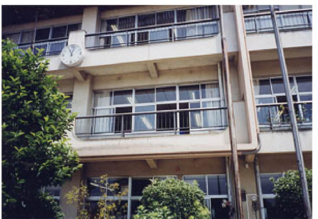
④2階北側 鉄骨ブレース設置前 外観
