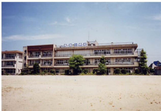
①東校舎南側外観 改修前
