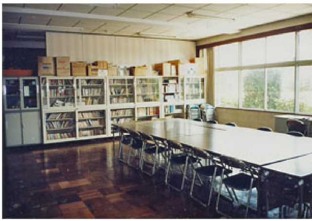
⑧ 1階会議室 改修前
