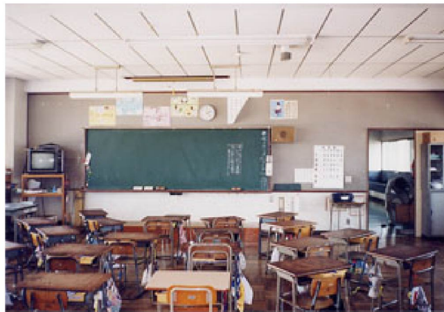
⑩ 2階3年1組内 改修前 (ブロック壁)
