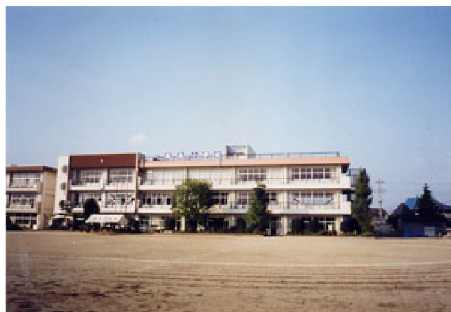
①東校舎南側外観 改修後
