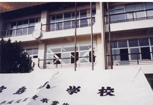
④2階北側 鉄骨ブレース設置後 外観
