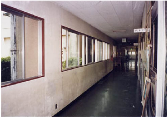
⑥1階廊下 改修前
