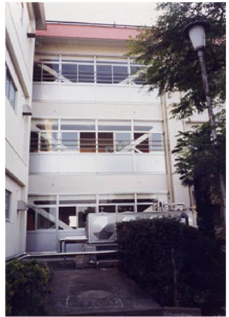
⑤南側鉄骨ブレース設置後
