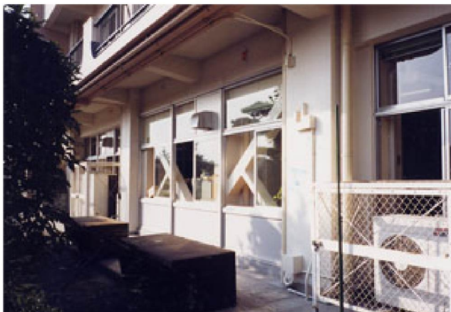
③1階北側 鉄骨ブレース設置後 外観
