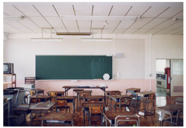
⑩ 2階3年1組内 改修後 (既設ブロック壁撤去、RC壁設置)
