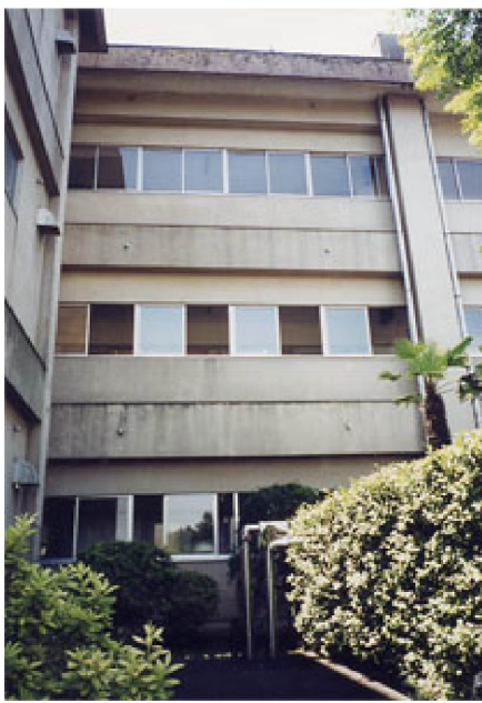
⑤南側鉄骨ブレース設置前
