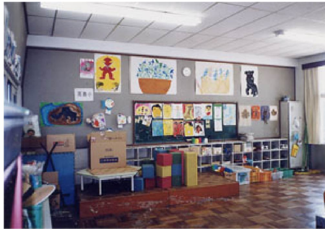
⑨ 1階資料室内 改修前 (ブロック壁)
