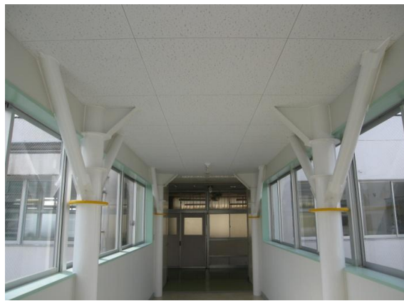
⑦施工後 2階内部
