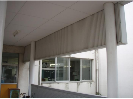
④施工前 1階内部
