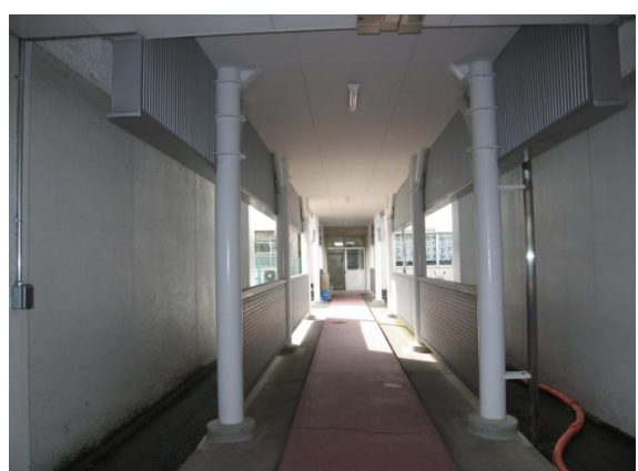
③施工後 1階内部
