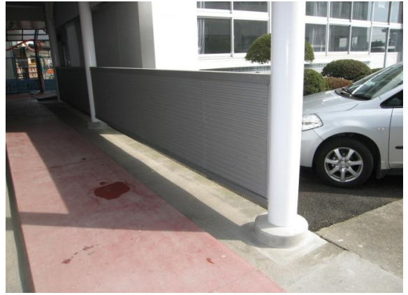
⑤施工後 1階内部
