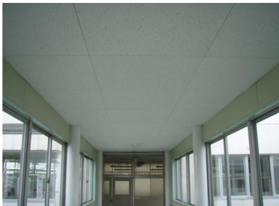
⑦施工前 2階内部
