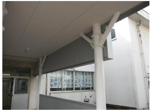
④施工後 1階内部
