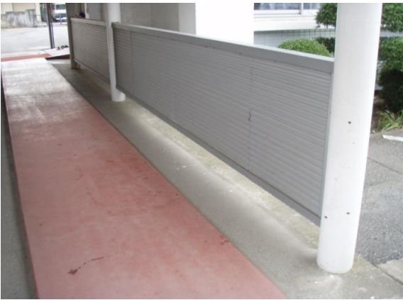
⑤施工前 1階内部
