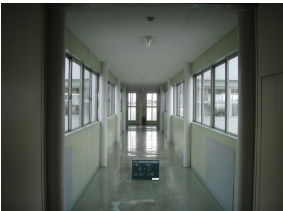
⑥施工前 2階内部
