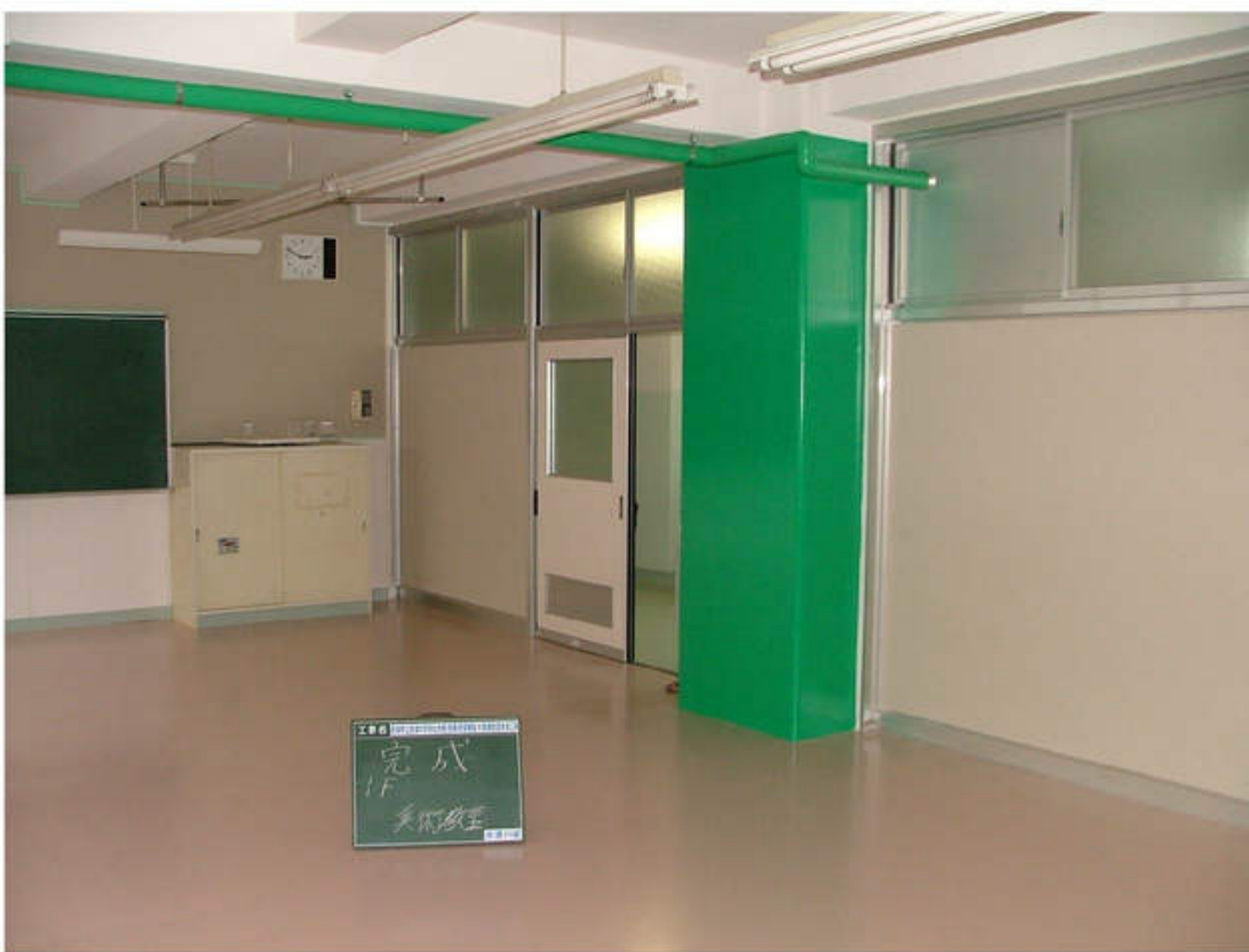
1階 美術室 柱鉄板巻き補強
