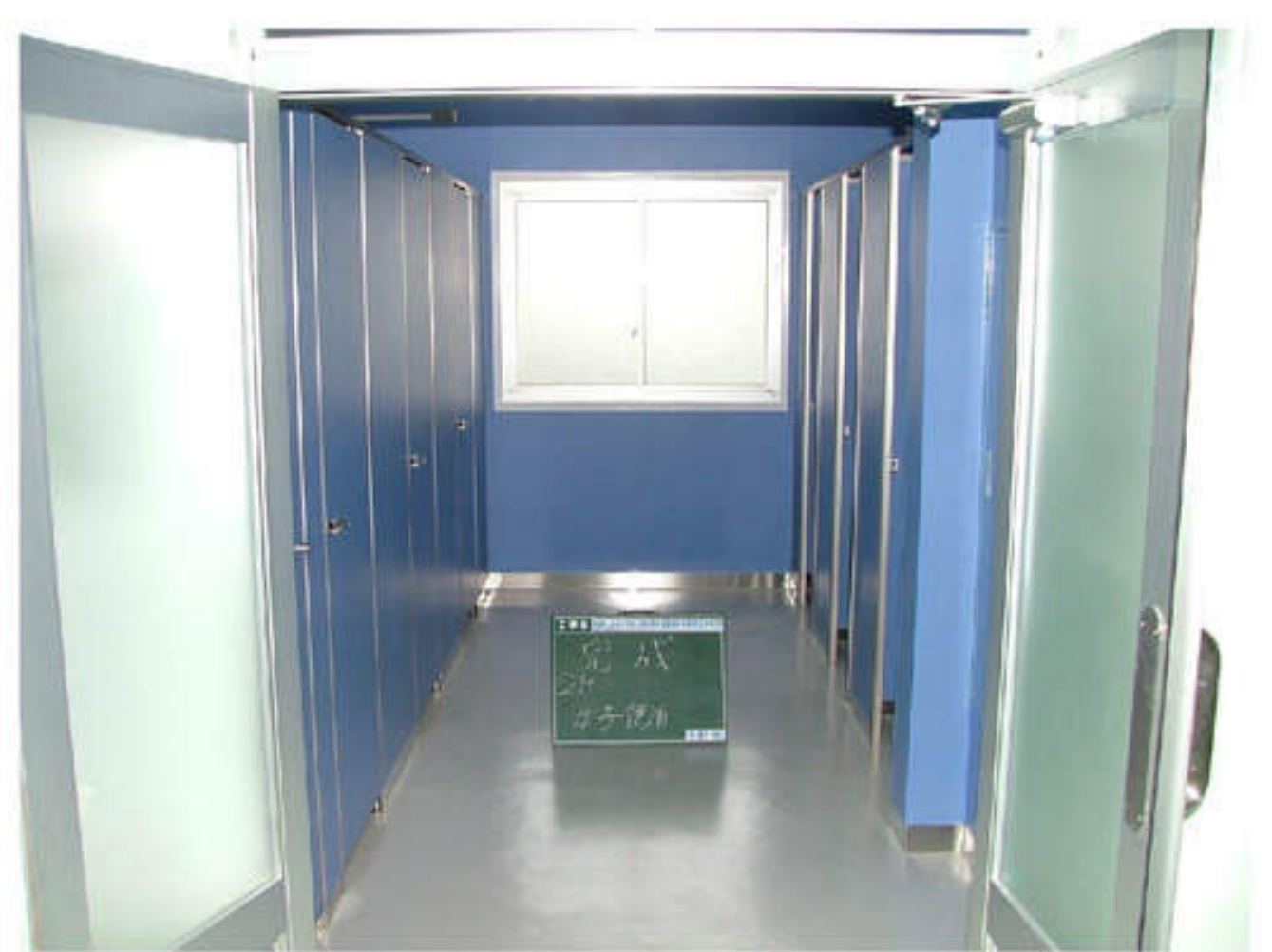
2階 女子トイレ 改修後
