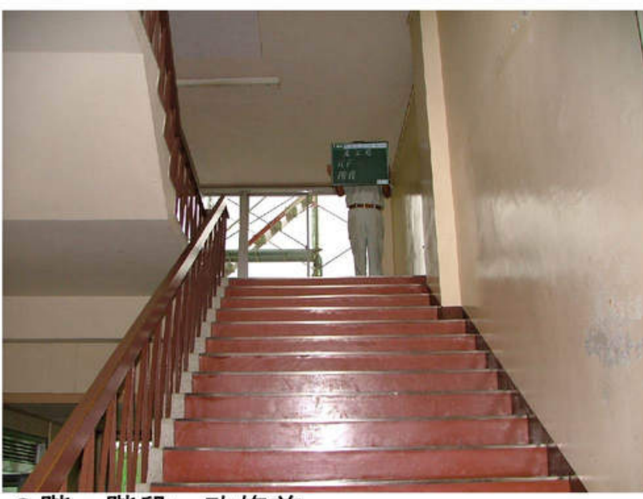
3階 階段 改修前
