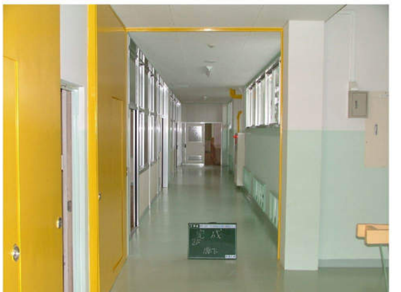
3階 廊下 改修後
