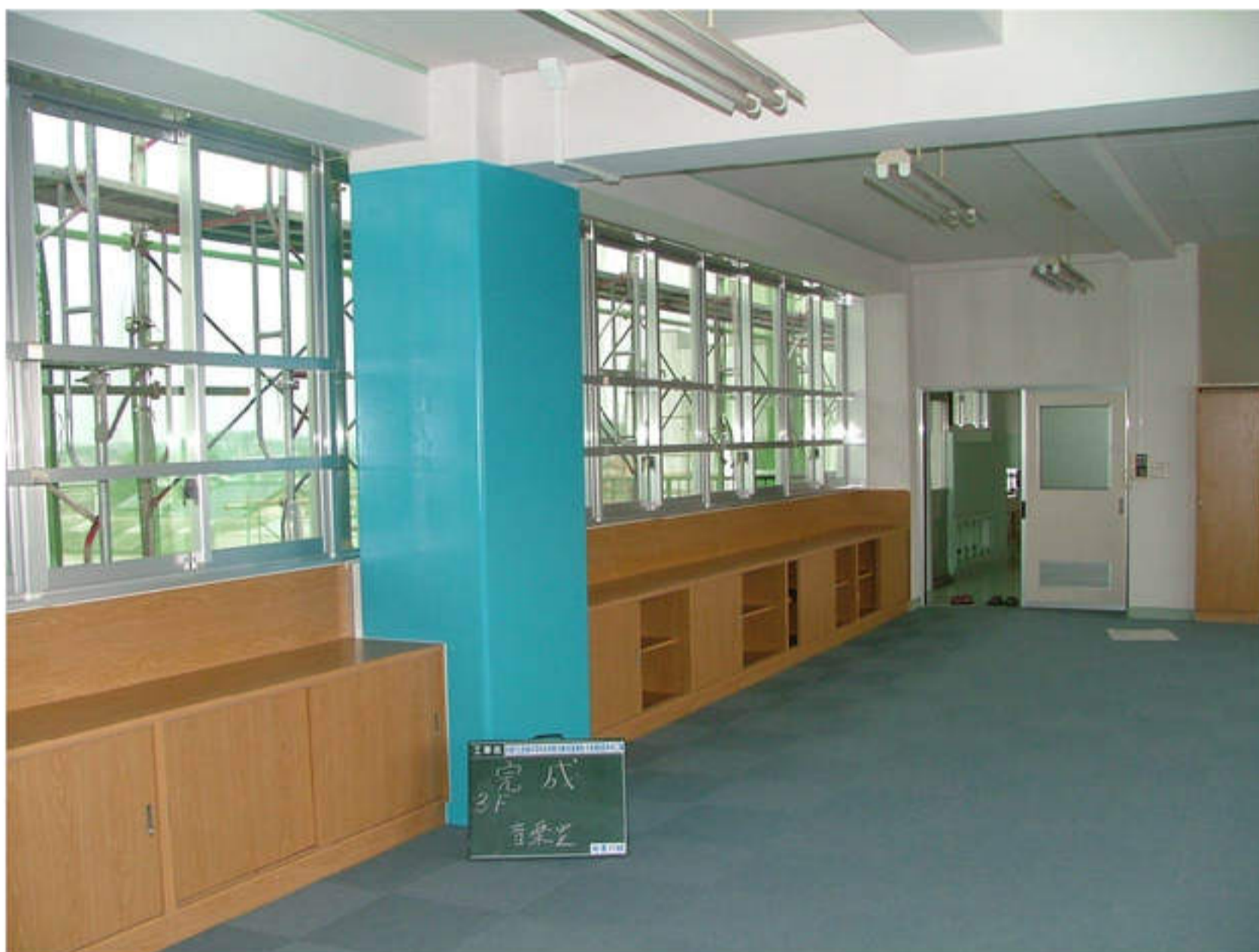
3階 音楽室 柱鉄板巻き補強
