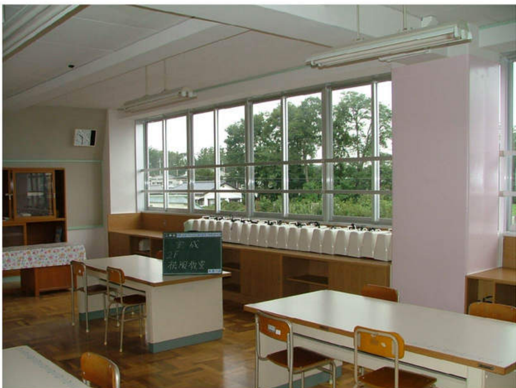
2階 被服室 鉄骨ブレース補強
