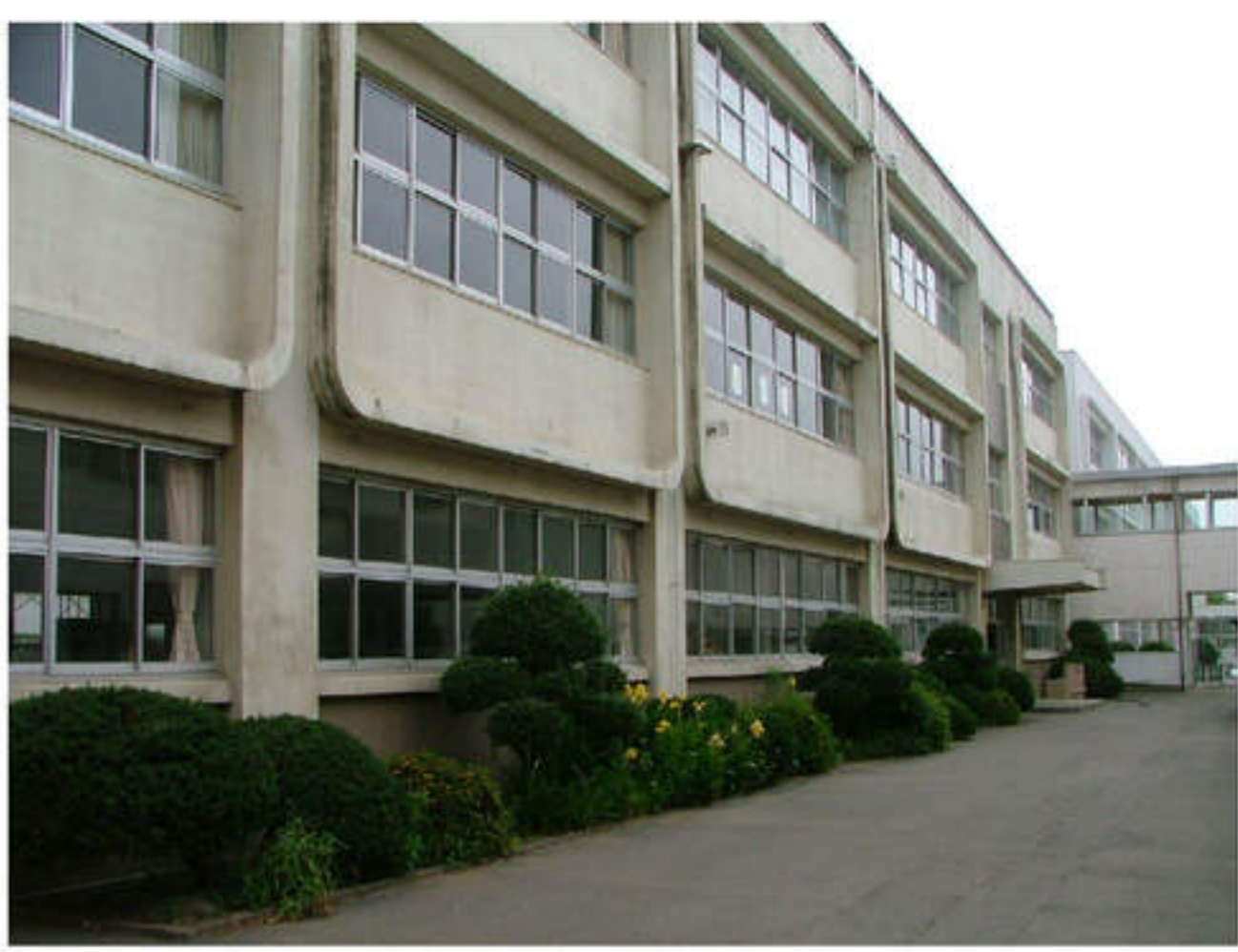
西棟 南面 改修前
