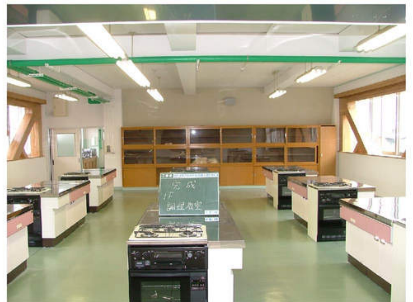
1階 家庭科室 改修後
