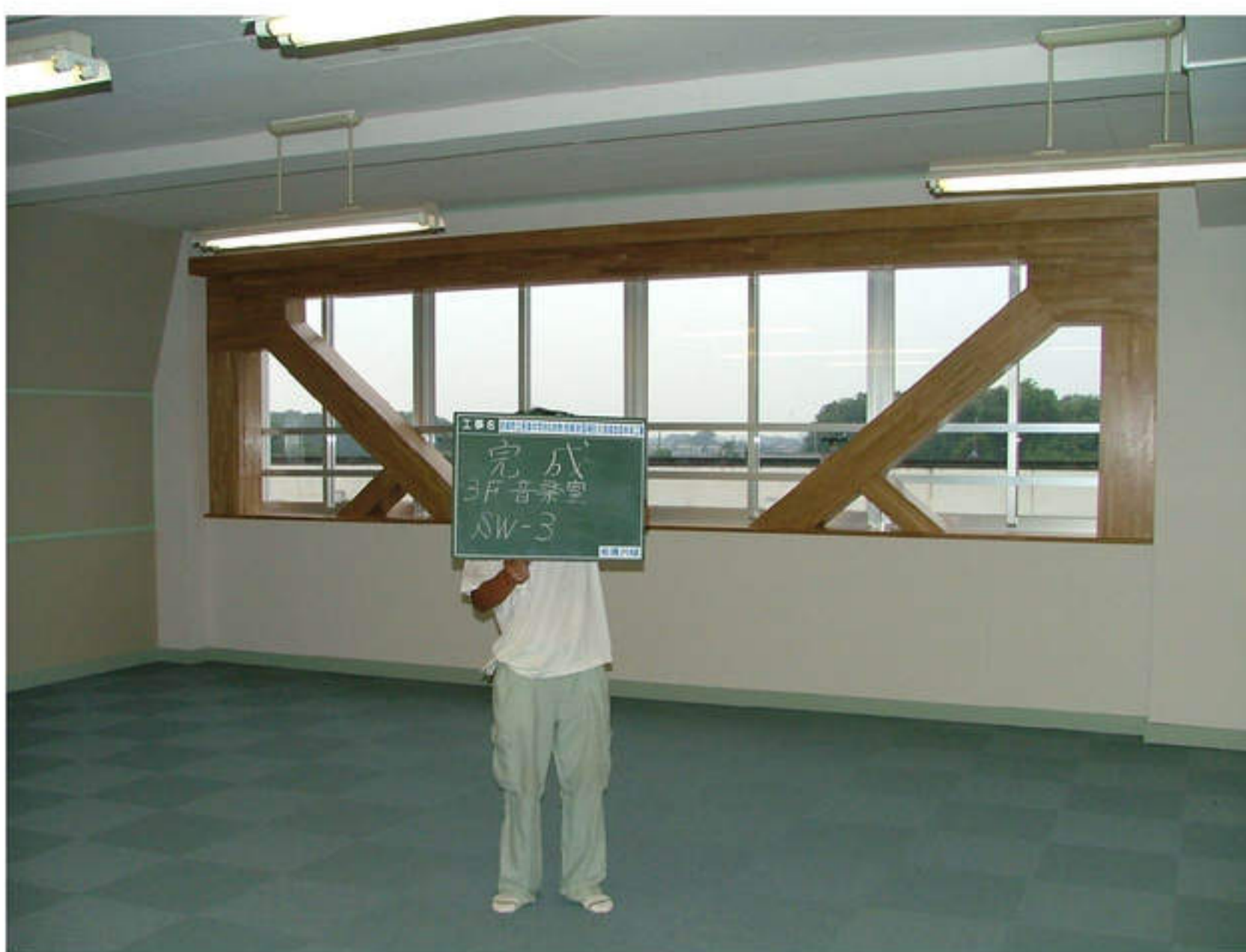
3階 音楽室 鉄骨ブレース補強
