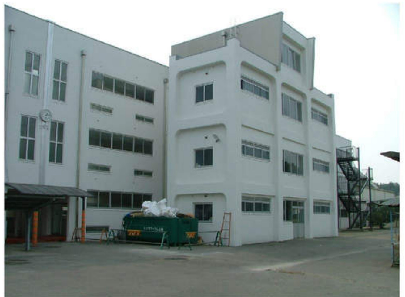
西棟 北面 改修後
