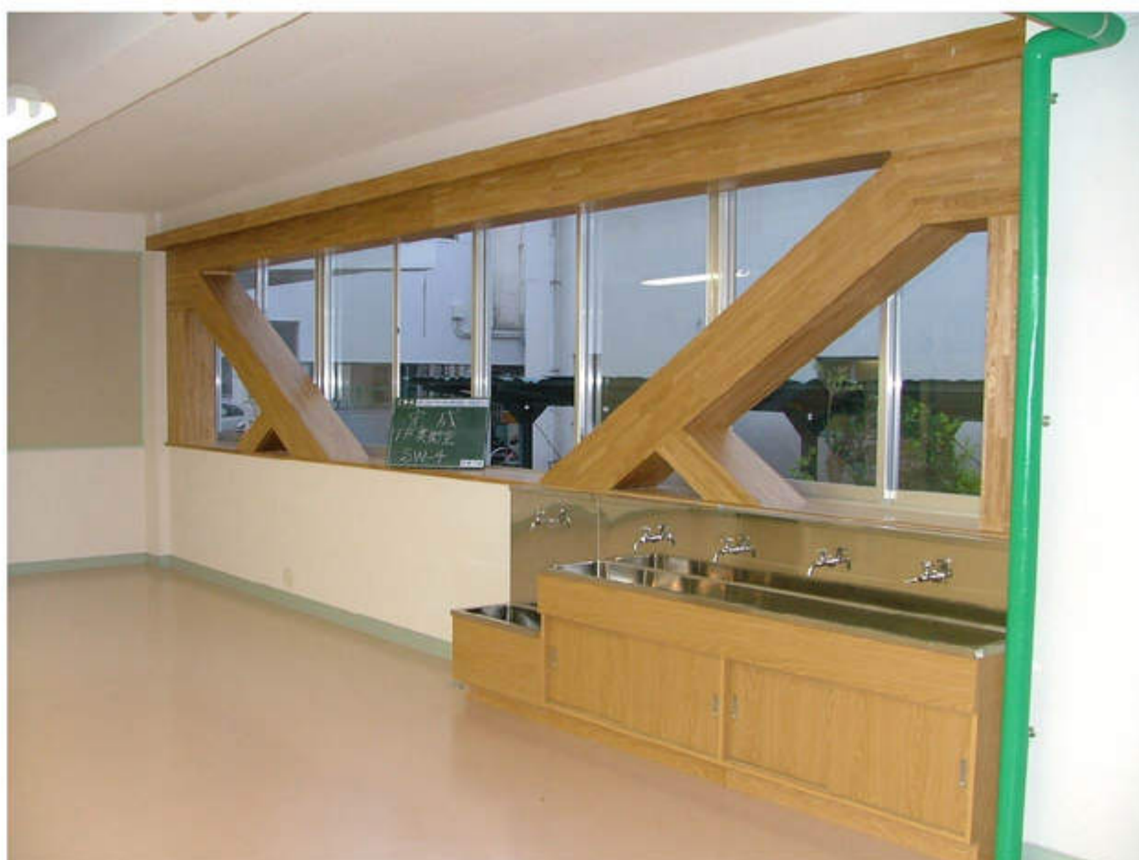
1階 美術室 鉄骨ブレース補強
