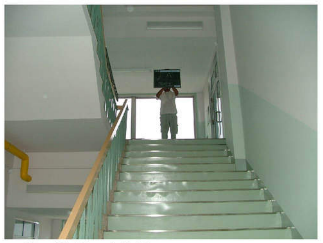
3階 階段 改修後
