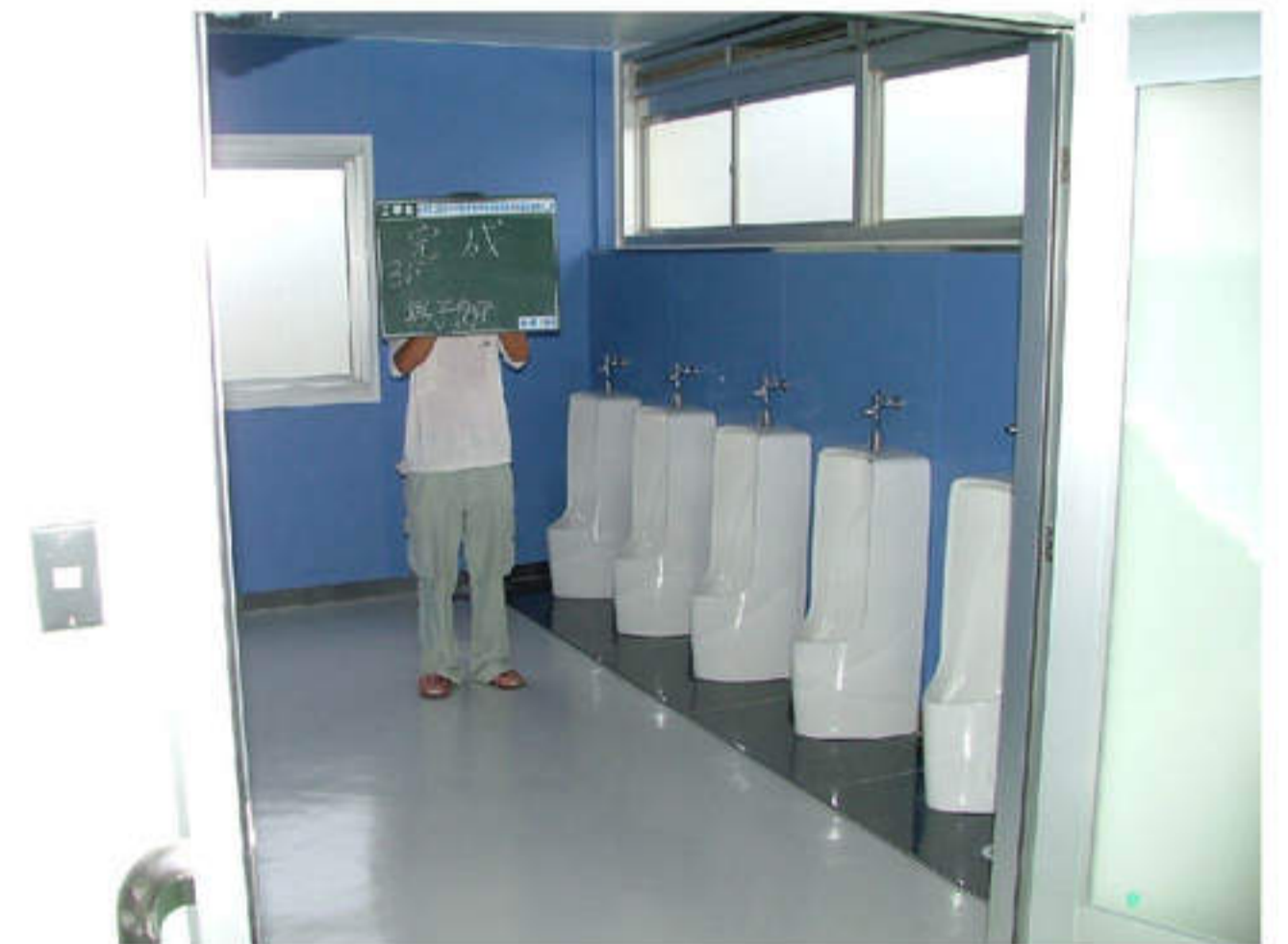
3階 男子トイレ 改修後
