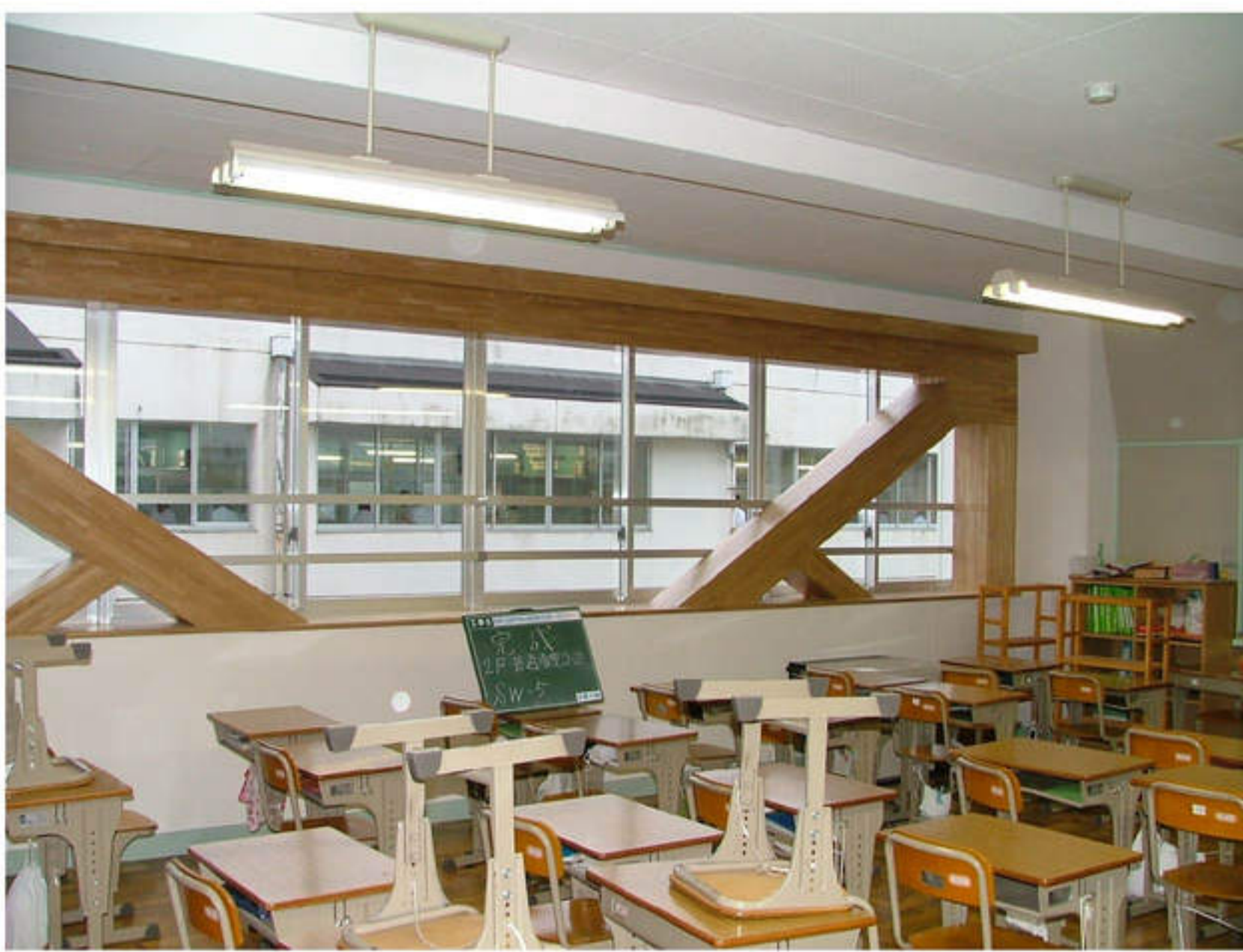
2階 普通教室 鉄骨ブレース補強
