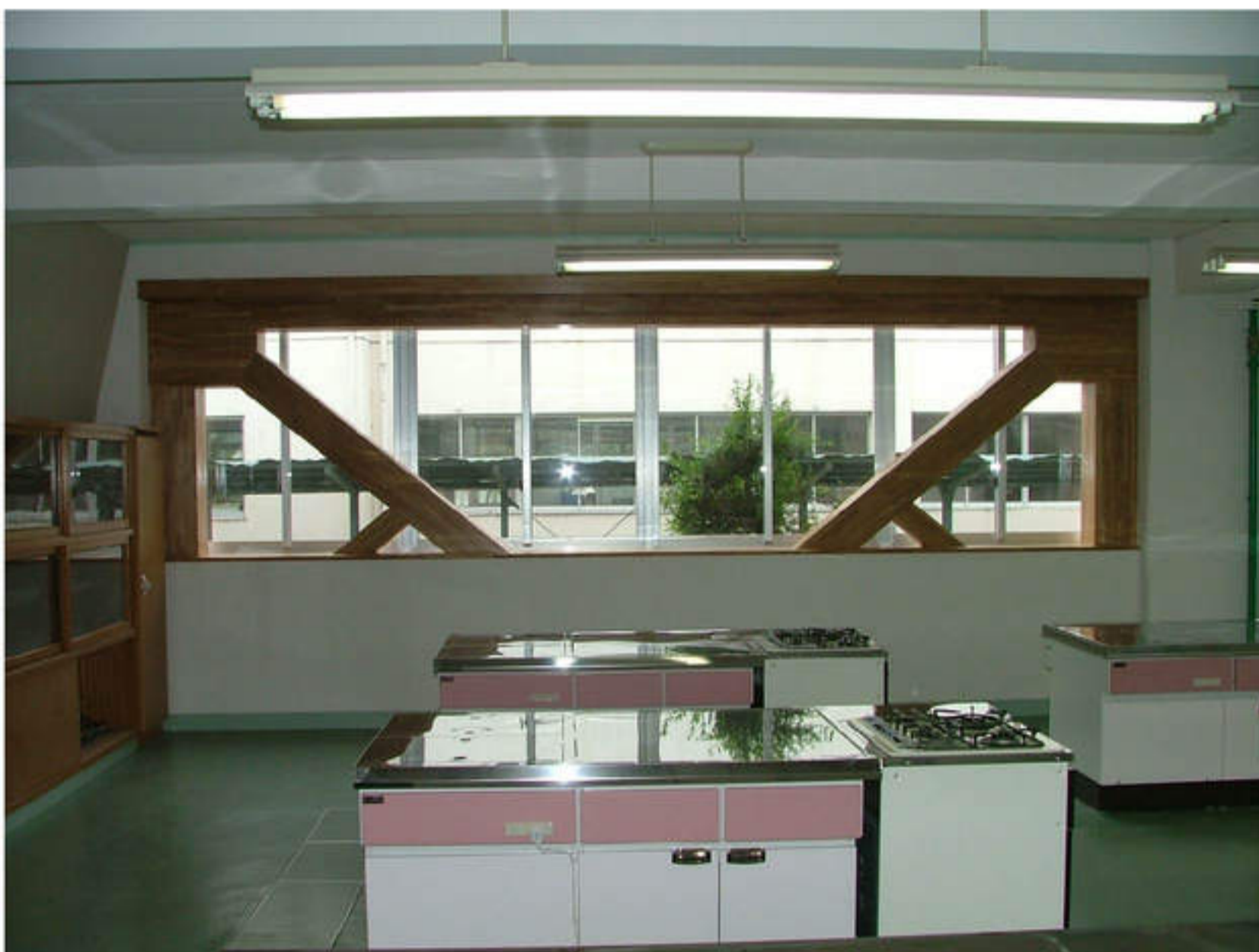
1階 家庭科室 南側 鉄骨ブレース補強
