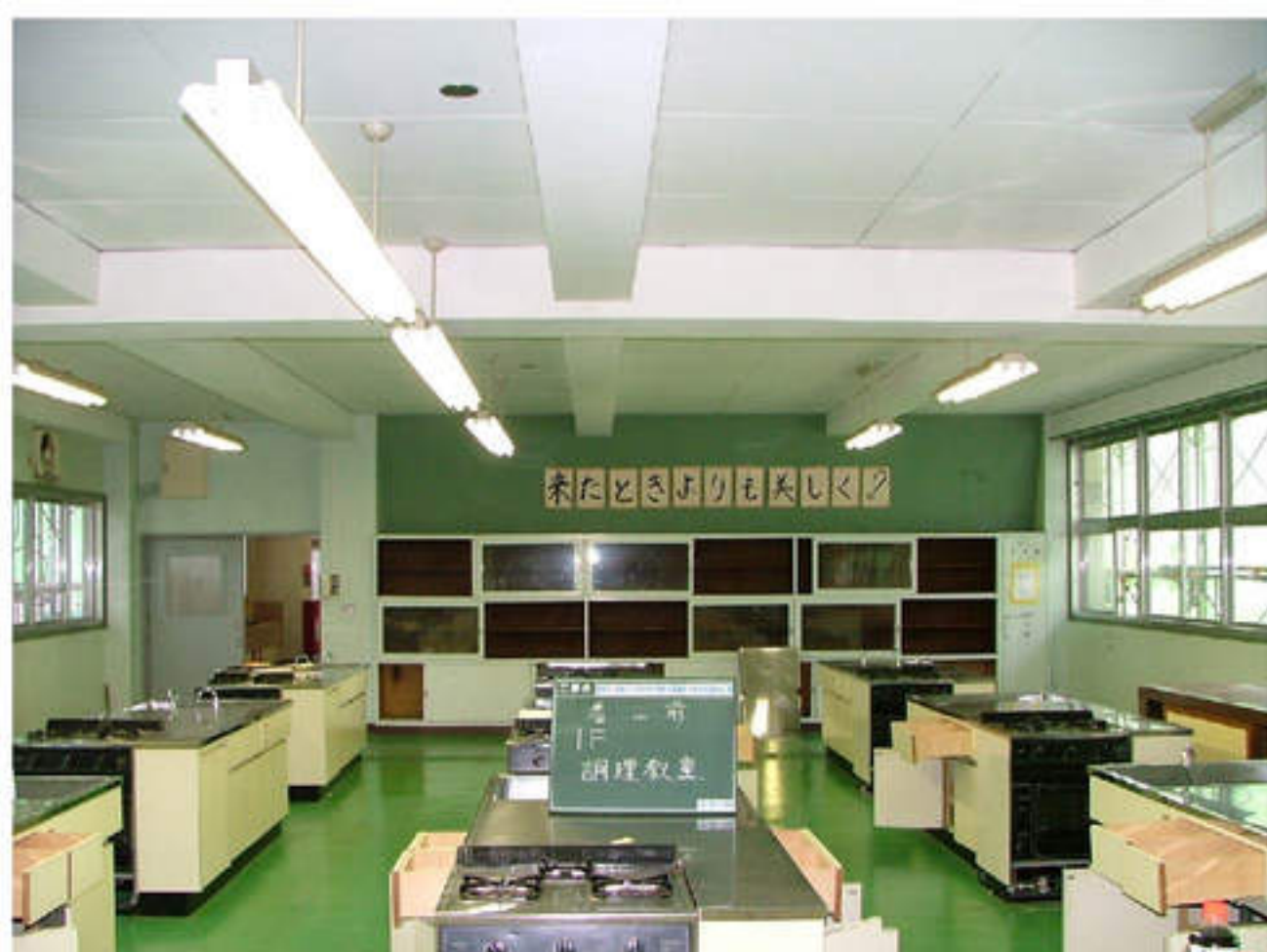
1階 家庭科室 改修前
