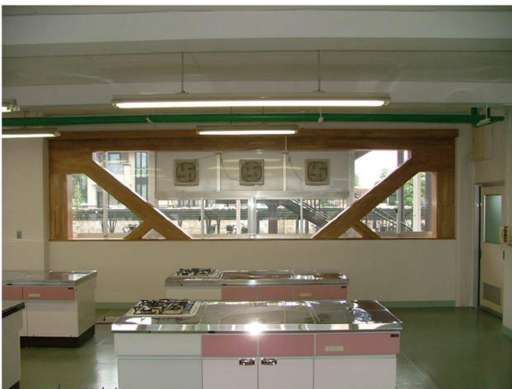
1階 家庭科室 北側 鉄骨ブレース補強
