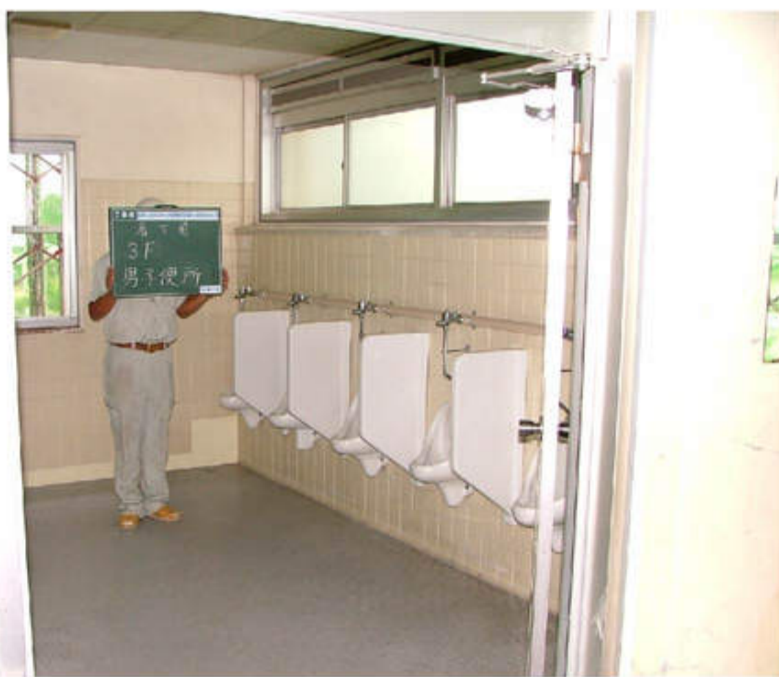
3階 男子トイレ 改修前
