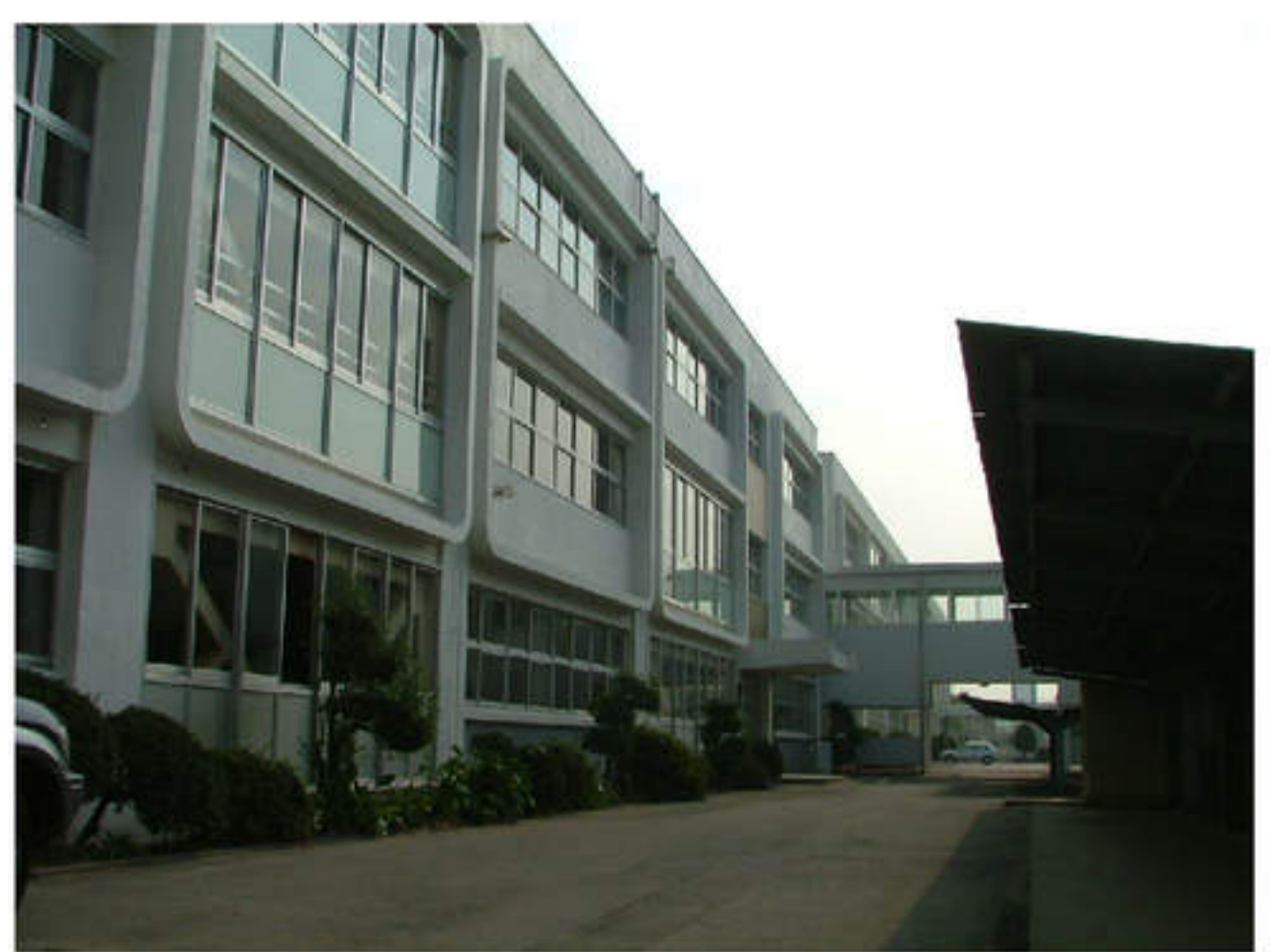
西棟 南面 改修後
