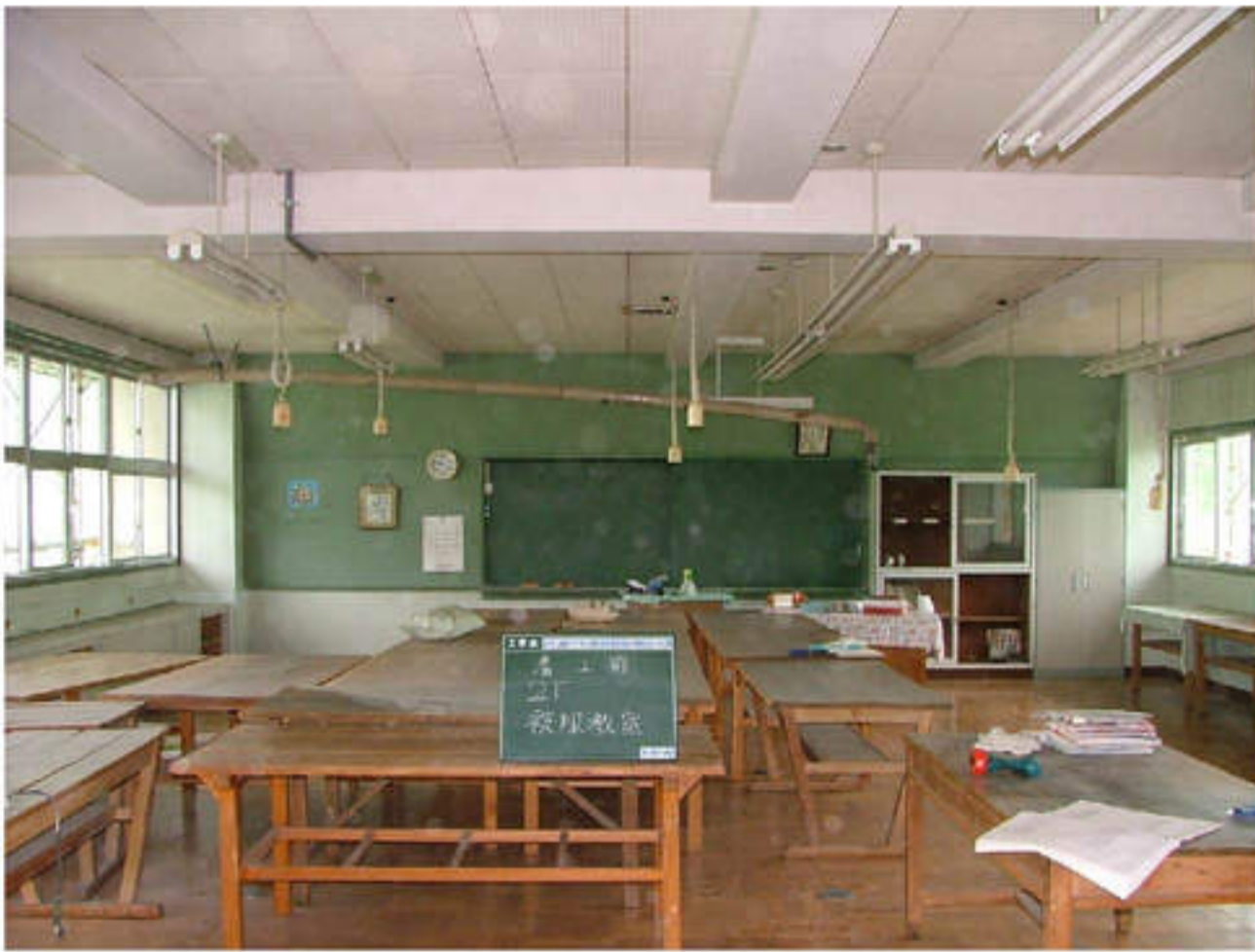
2階 被服室 改修前
