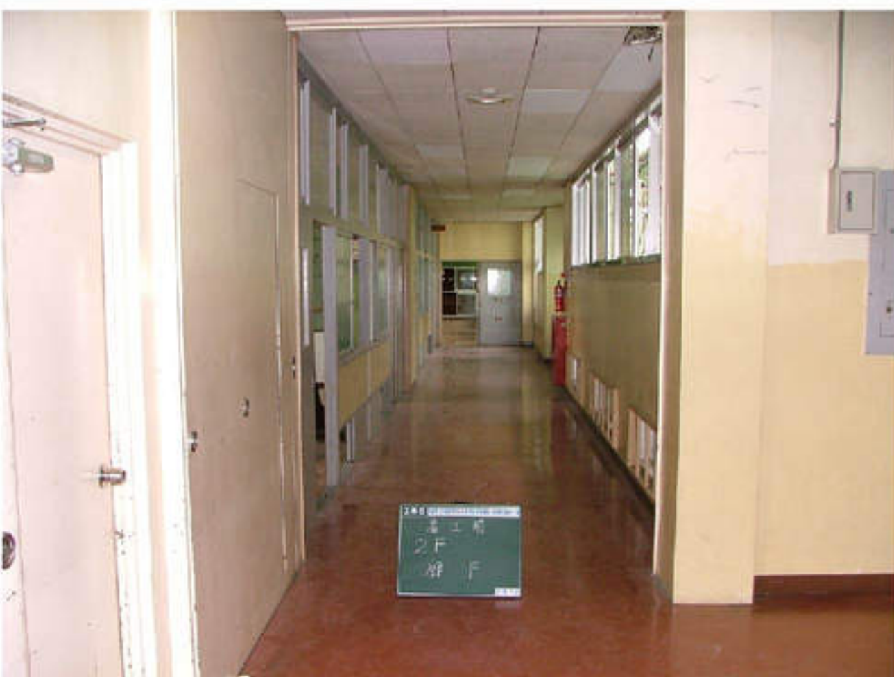
3階 廊下 改修前
