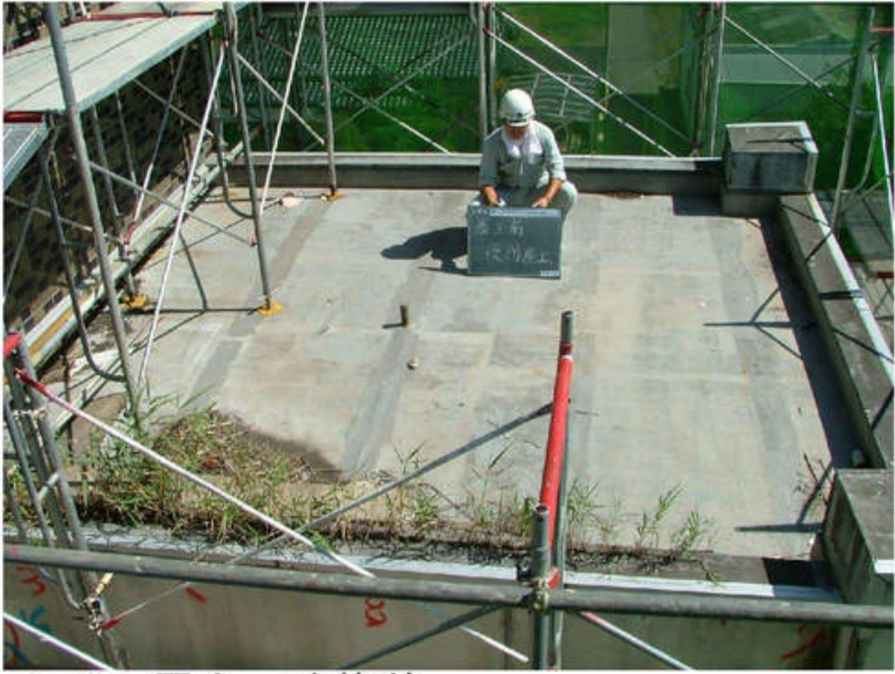
トイレ屋上 改修前
