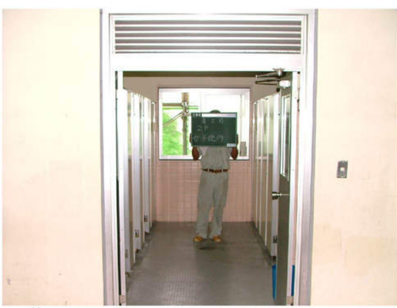
2階 女子トイレ 改修前
