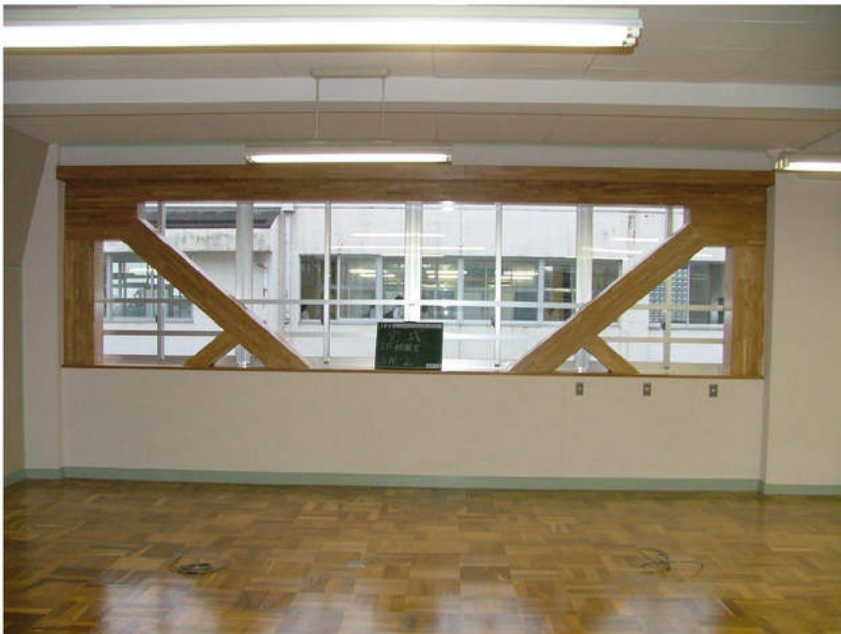
2階 被服室 鉄骨ブレース補強
