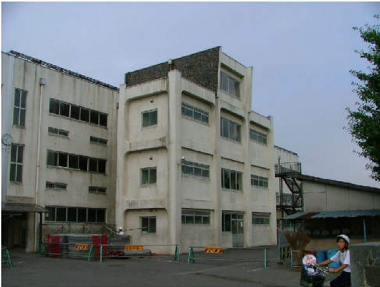
西棟 北面 改修前
