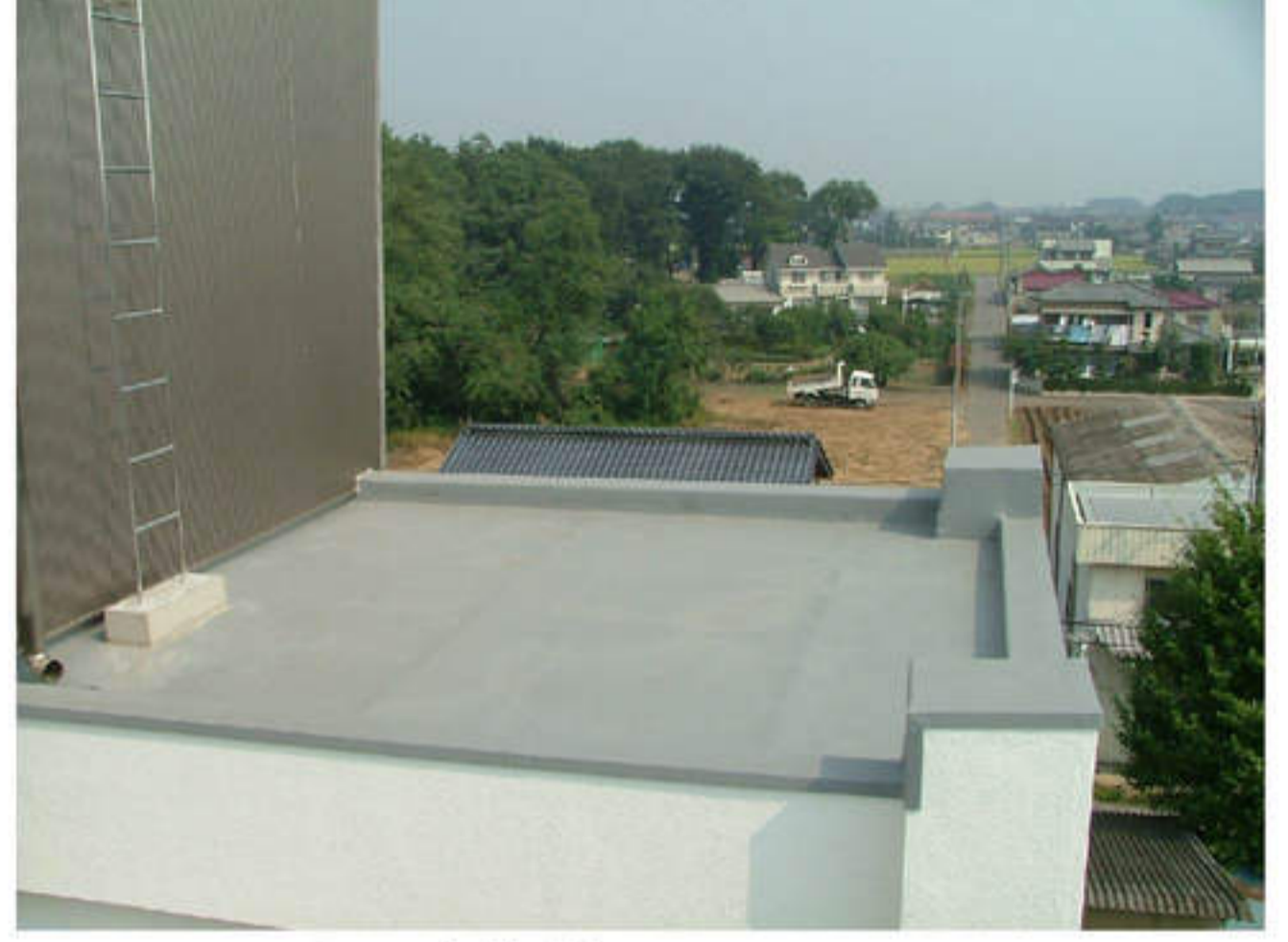
トイレ屋上 改修後
