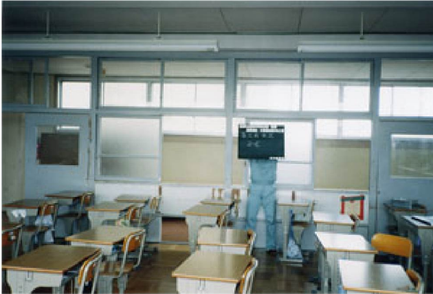
⑥北校舎（東棟）2階 普通教室 改修前
