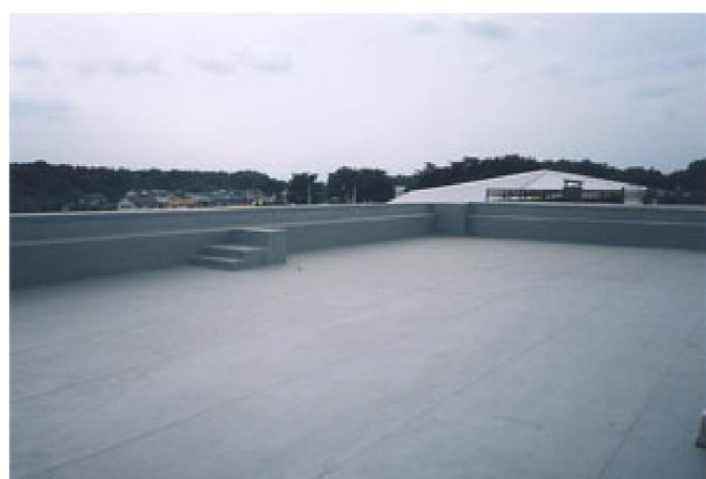
④北校舎（東棟）屋上防水 改修後
