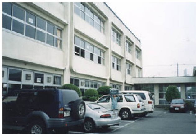
①北校舎（東棟）南側外観 改修前
