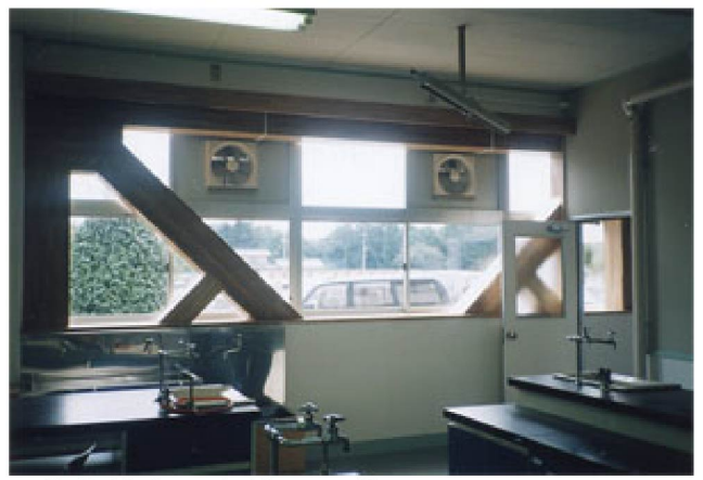
⑤北校舎（東棟）1階 第2理科室 改修後 鉄骨ブレース
