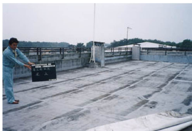
④北校舎（東棟）屋上防水 改修前
