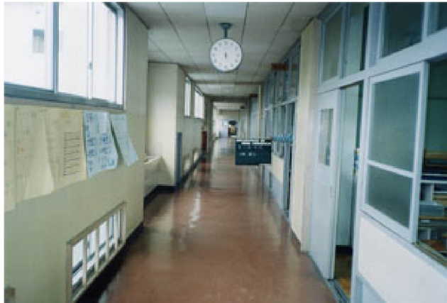
⑦北校舎（東棟）2階 廊下 改修前
