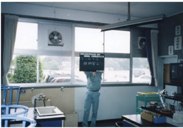
⑤北校舎（東棟）1階 第2理科室 改修前
