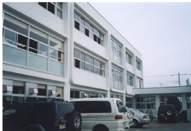
①北校舎（東棟）南側外観 改修後
