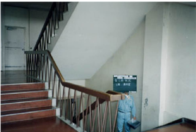
⑧北校舎（東棟）3階 階段 改修前
