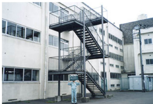
②北校舎（東棟）北側外観 改修前
