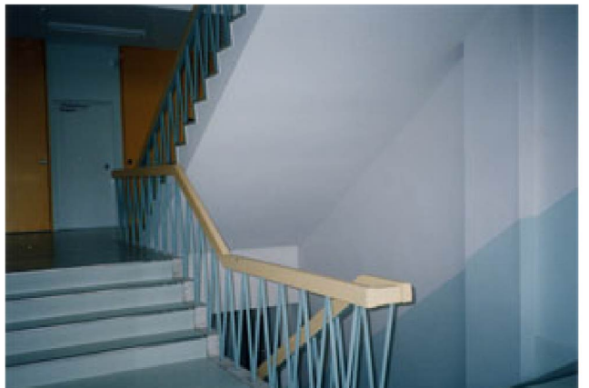
⑧北校舎（東棟）3階 階段 改修後
