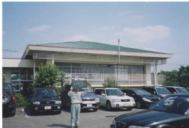
③北校舎（東棟）図書室外観 改修前
