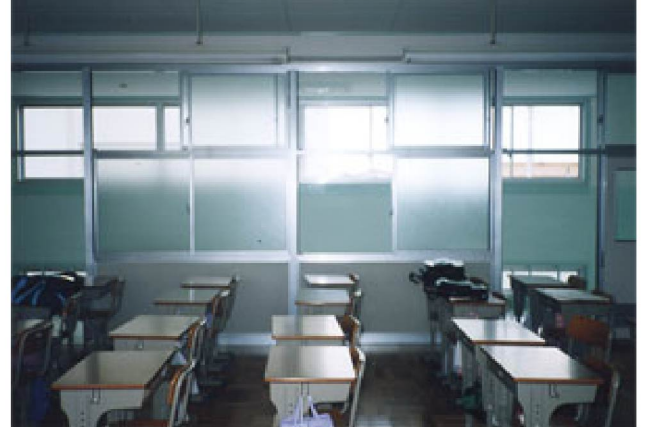
⑥北校舎（東棟）2階 普通教室 改修後
