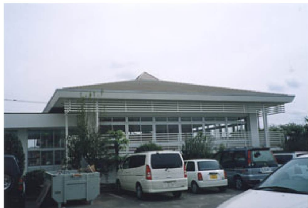
③北校舎（東棟）図書室外観 改修後
