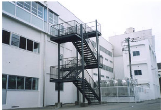
②北校舎（東棟）北側外観 改修後
