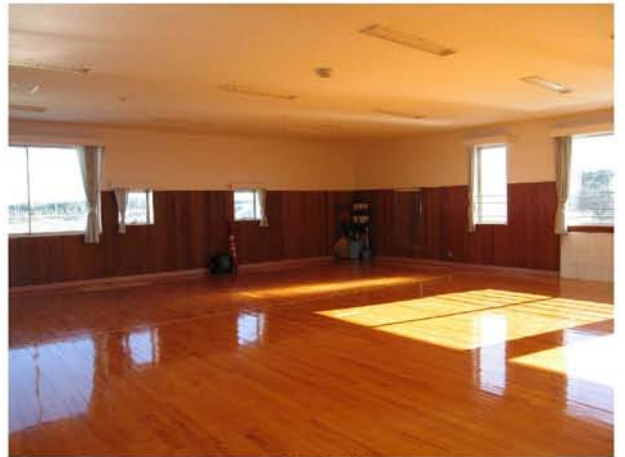
⑥ A通り、1通り 鉄骨ブレース、 屋根ブレース設置後（2階剣道場）
