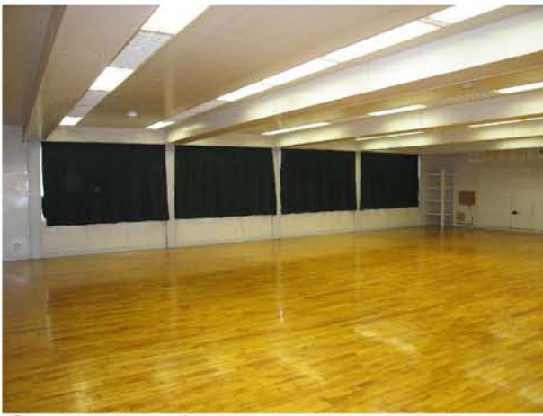
⑤ 1通り鉄骨ブレース設置前（卓球場）
