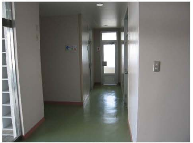
① トイレ出入口付近改修後
