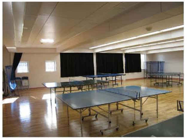
⑤ 1通り鉄骨ブレース設置後（卓球場）
