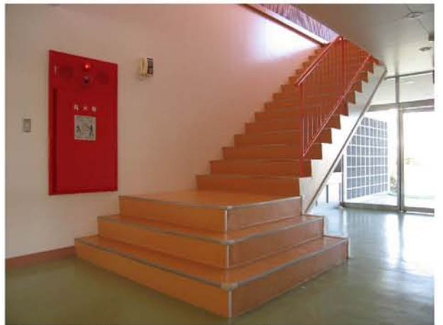
④2通りブレース設置後（階段周辺）
