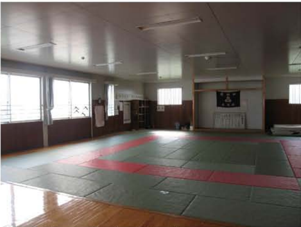
⑦ B通り、1通り 鉄骨ブレース、 屋根ブレース設置前（2階柔道場）
