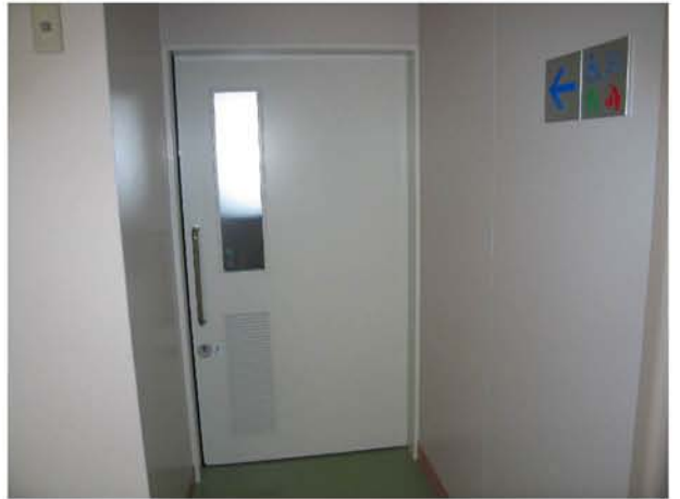
③ 多目的トイレ（新設）出入口改修後
