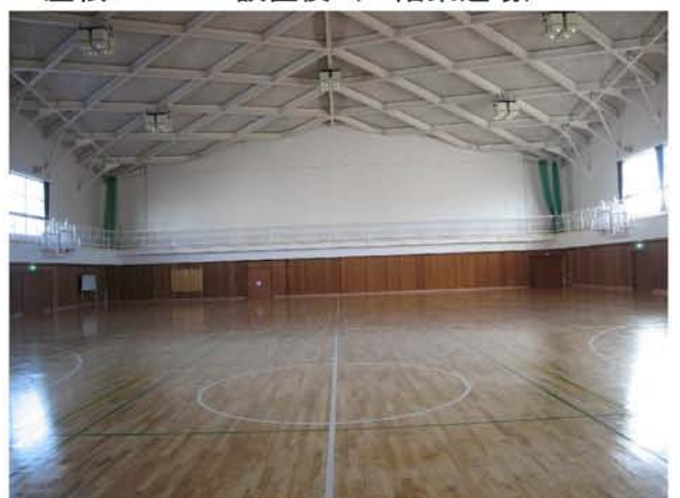
⑧ 2通り 鉄骨ブレース設置後（アリーナ）
