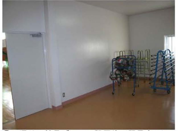
⑩ 3通り 鉄骨ブレース設置後 (器具庫A)
