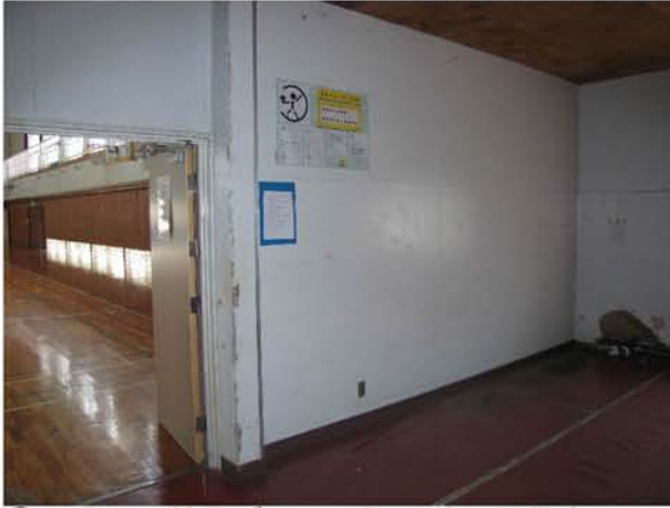
⑩ 3通り 鉄骨ブレース設置前 (器具庫A)
