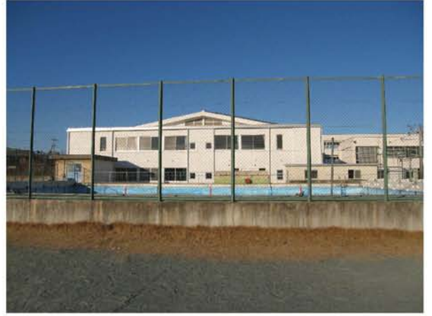
②屋内運動場南側外観改修後
