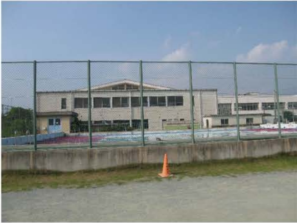
②屋内運動場南側外観改修前
