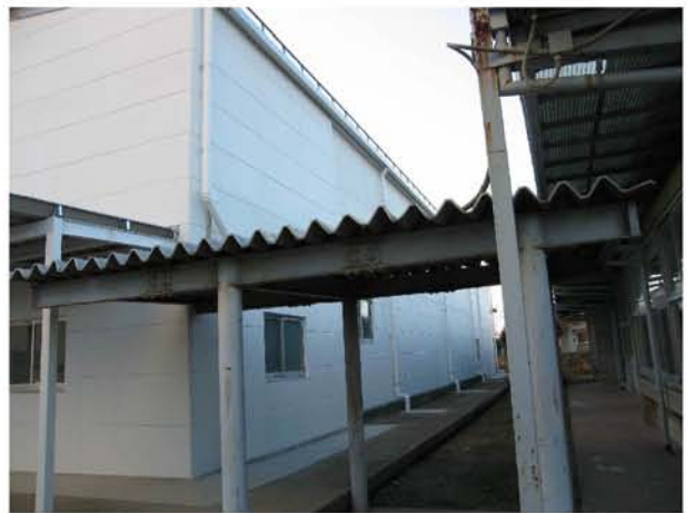
③屋内運動場北側外観改修後
