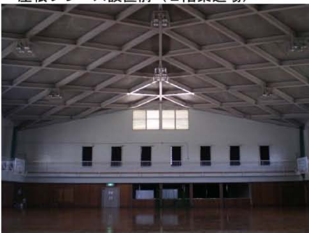
⑧ 2通り 鉄骨ブレース設置前（アリーナ）
