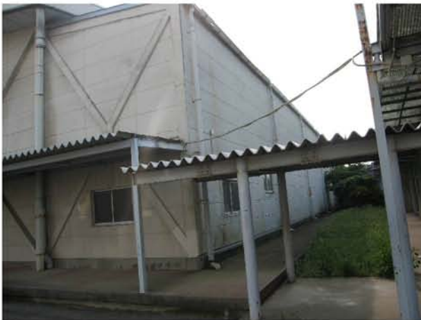
③屋内運動場北側外観改修前
