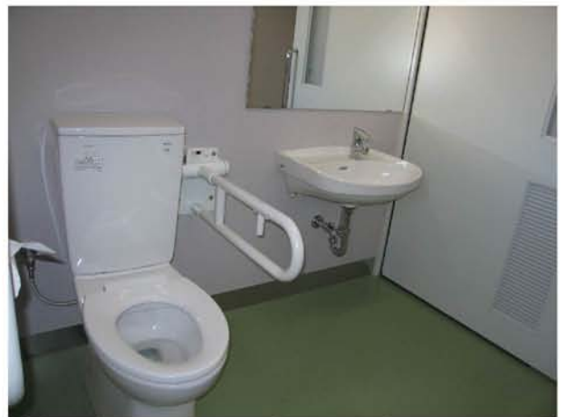
⑤ 新設多目的トイレ（新設）内部
