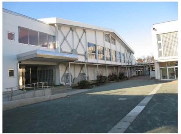
①屋内運動場東側外観改修後
