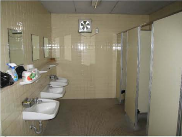
② 女子トイレ改修前
