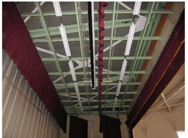
⑫ ステージ 屋根ブレース設置後
