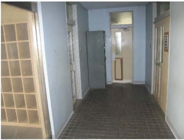
① トイレ出入口付近改修前
