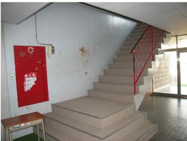
④2通りブレース設置前（階段周辺）
