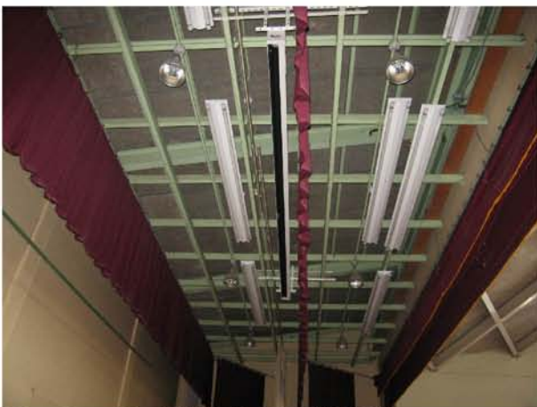
⑫ ステージ 屋根ブレース設置前
