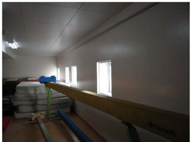
⑪ B通り 鉄骨ブレース設置後 (器具庫B)
