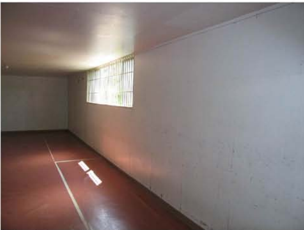
⑪ B通り 鉄骨ブレース設置前 (器具庫B)
