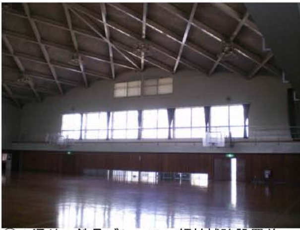
⑨ A通り 鉄骨ブレース、頬杖補強設置前 (アリーナ東面)
