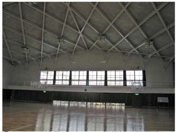
⑨ A通り 鉄骨ブレース、頬杖補強設置後 (1階アリーナ西面)
