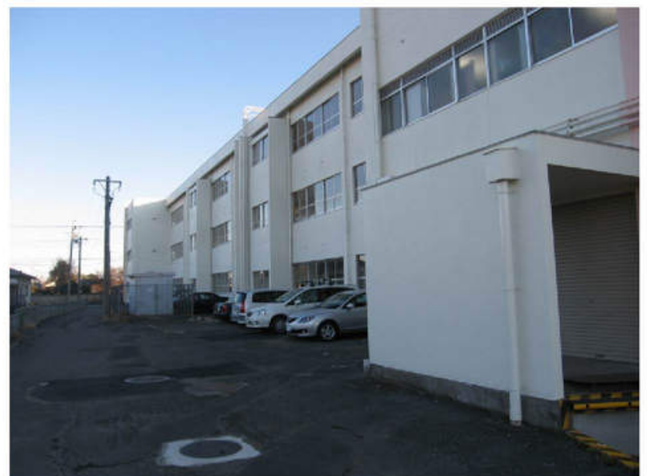
③北校舎東棟北西側改修後
