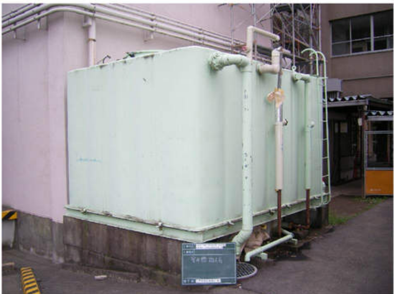
⑫受水槽改修前
