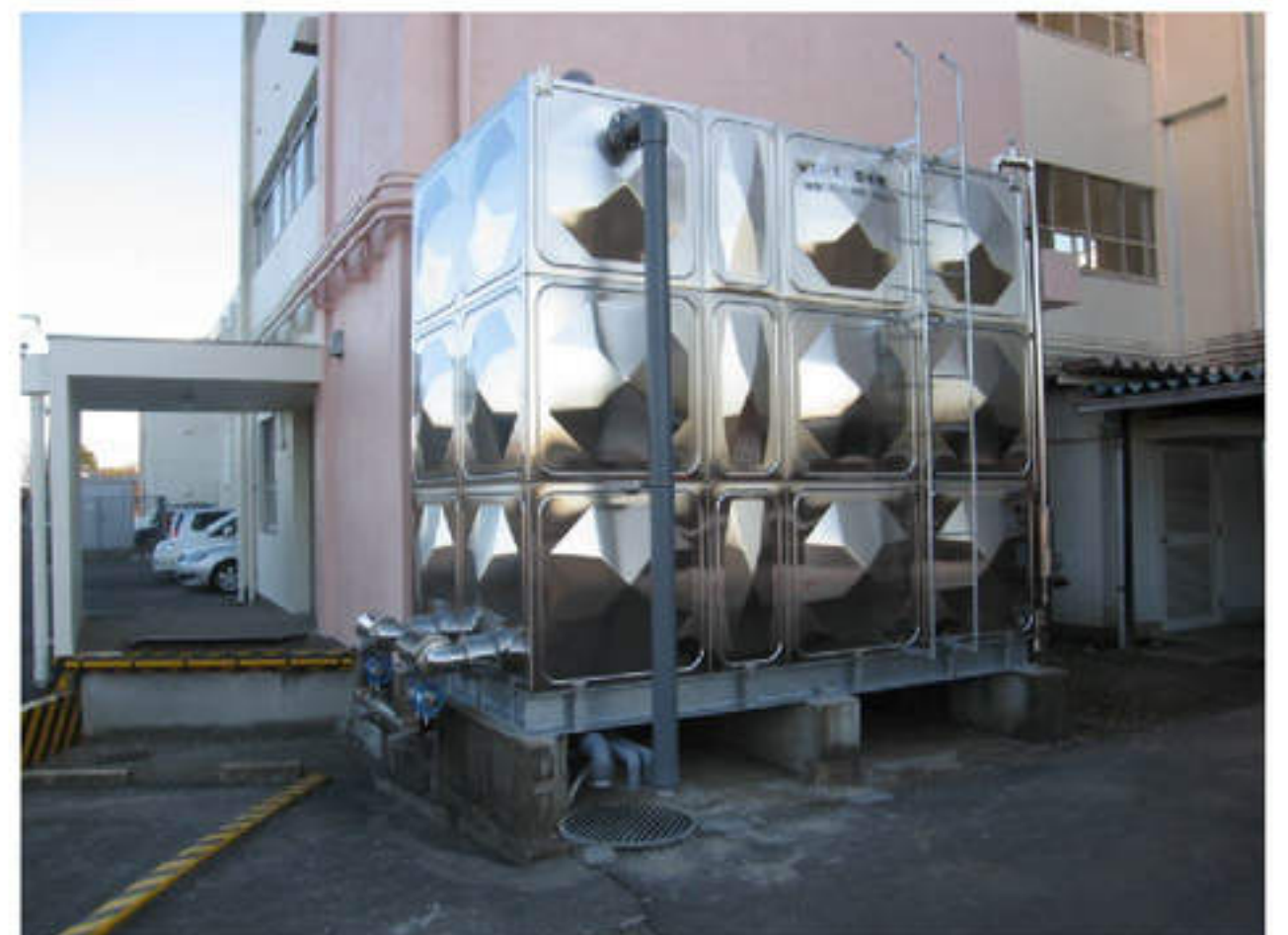
⑫受水槽改修後
