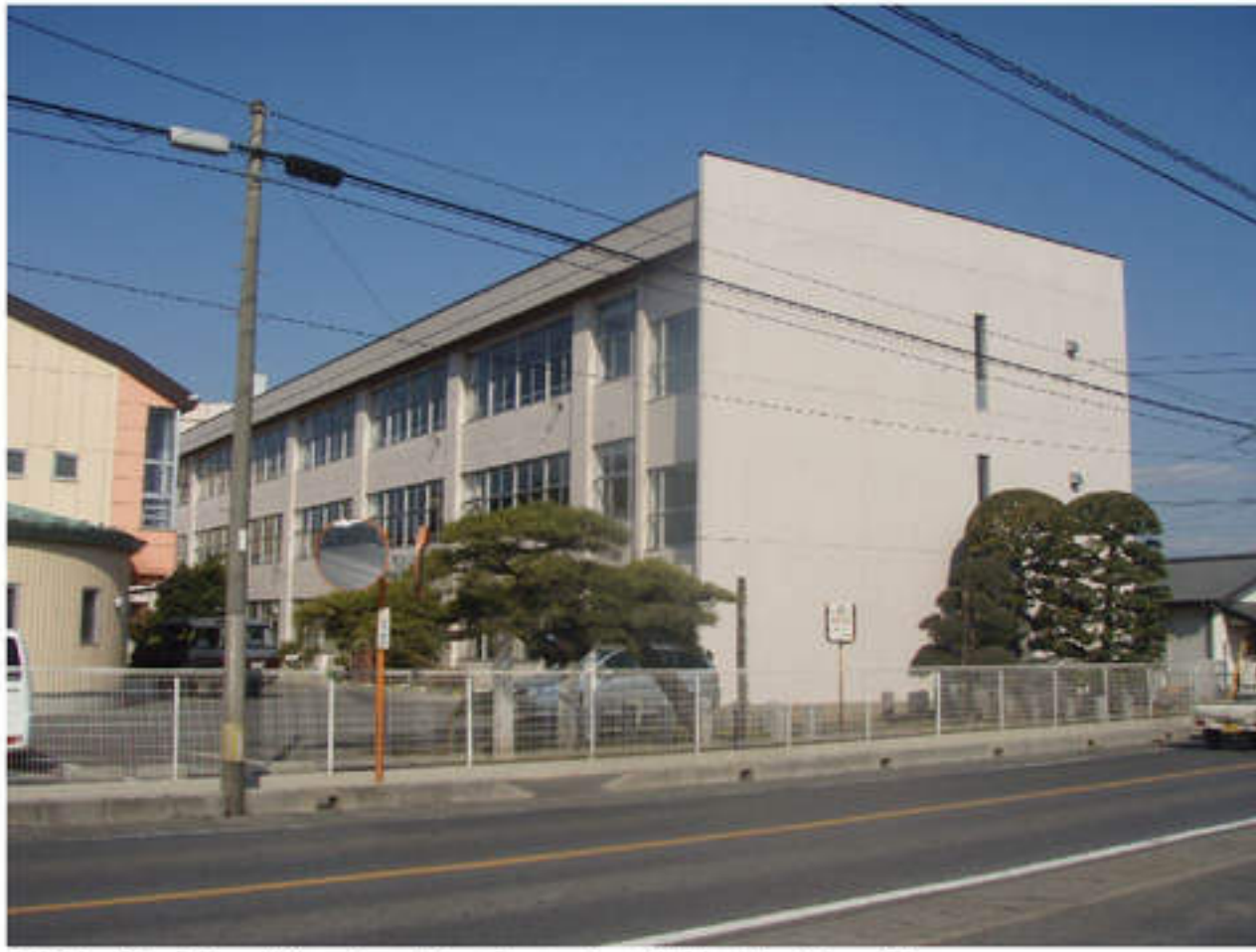
②北校舎東棟南東側改修前
