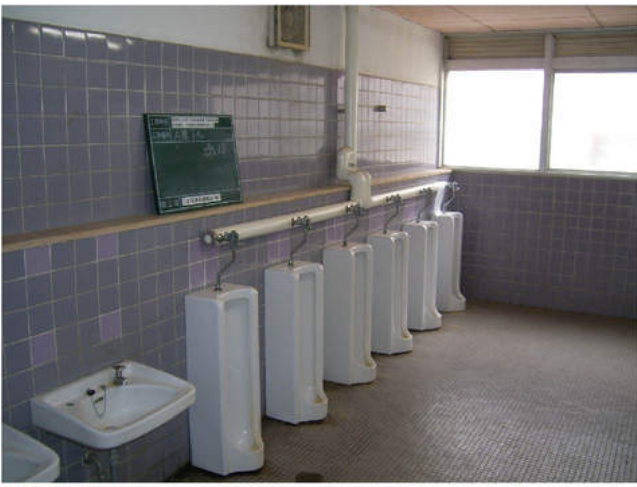
⑤南校舎トイレ改修前
