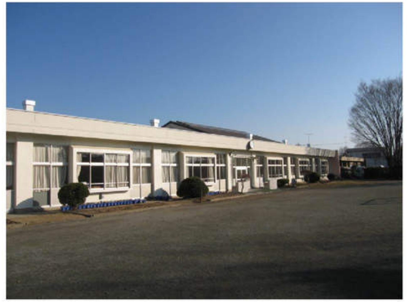
①南校舎改修後
