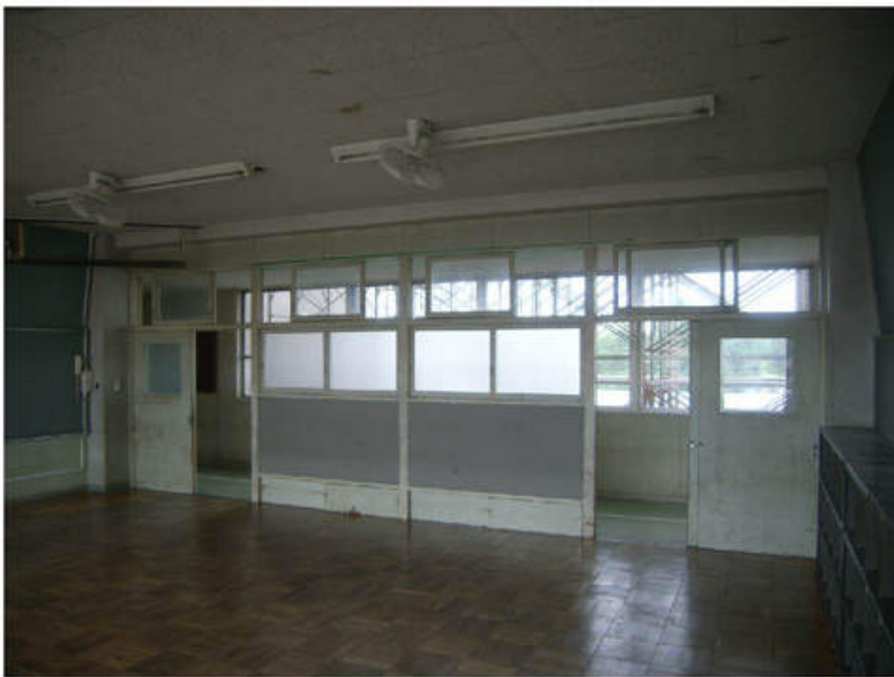
⑦北校舎東棟教室間仕切り改修前
