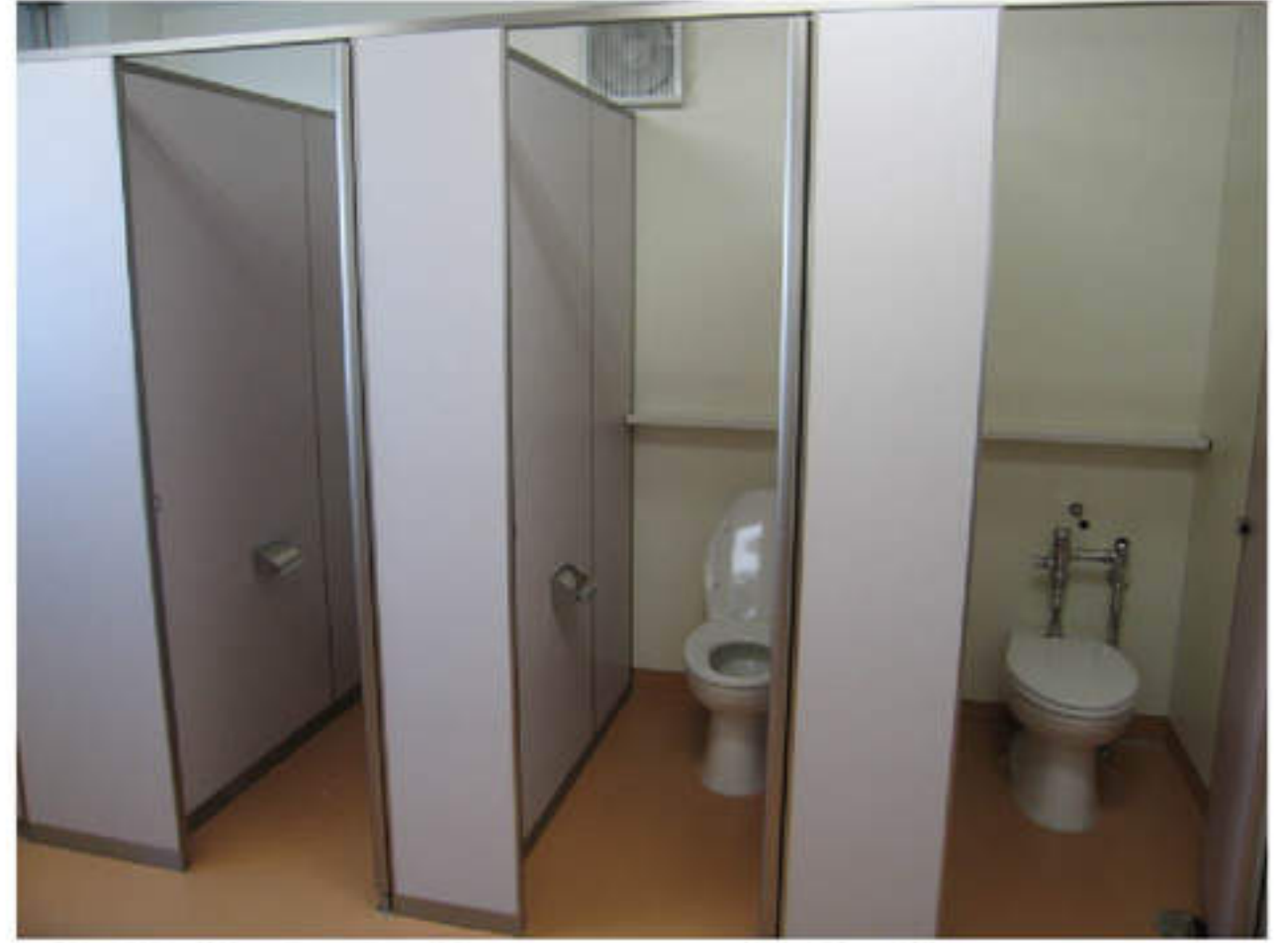
⑥北校舎東棟トイレ改修後
