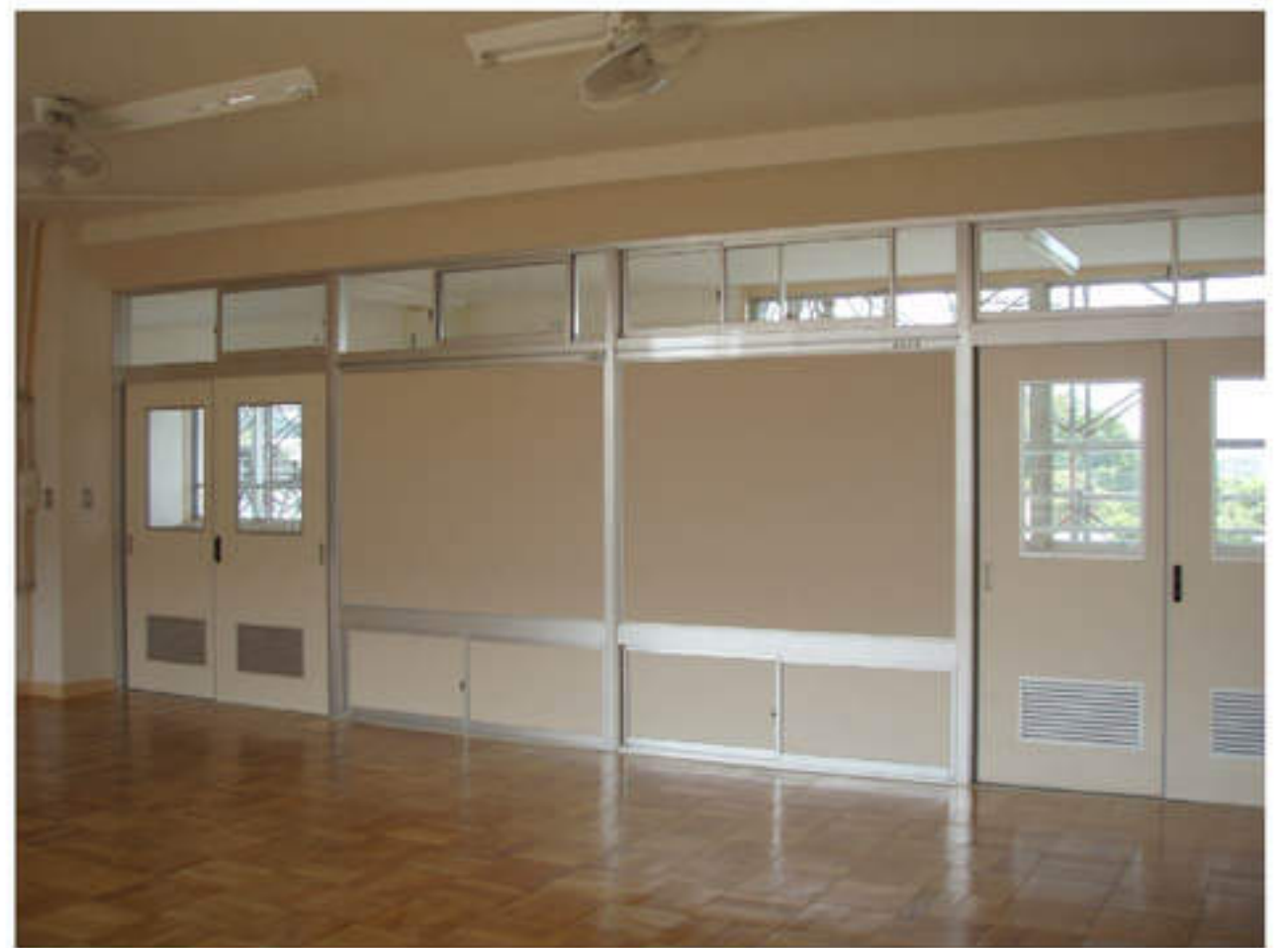
⑦北校舎東棟教室間仕切り改修後
