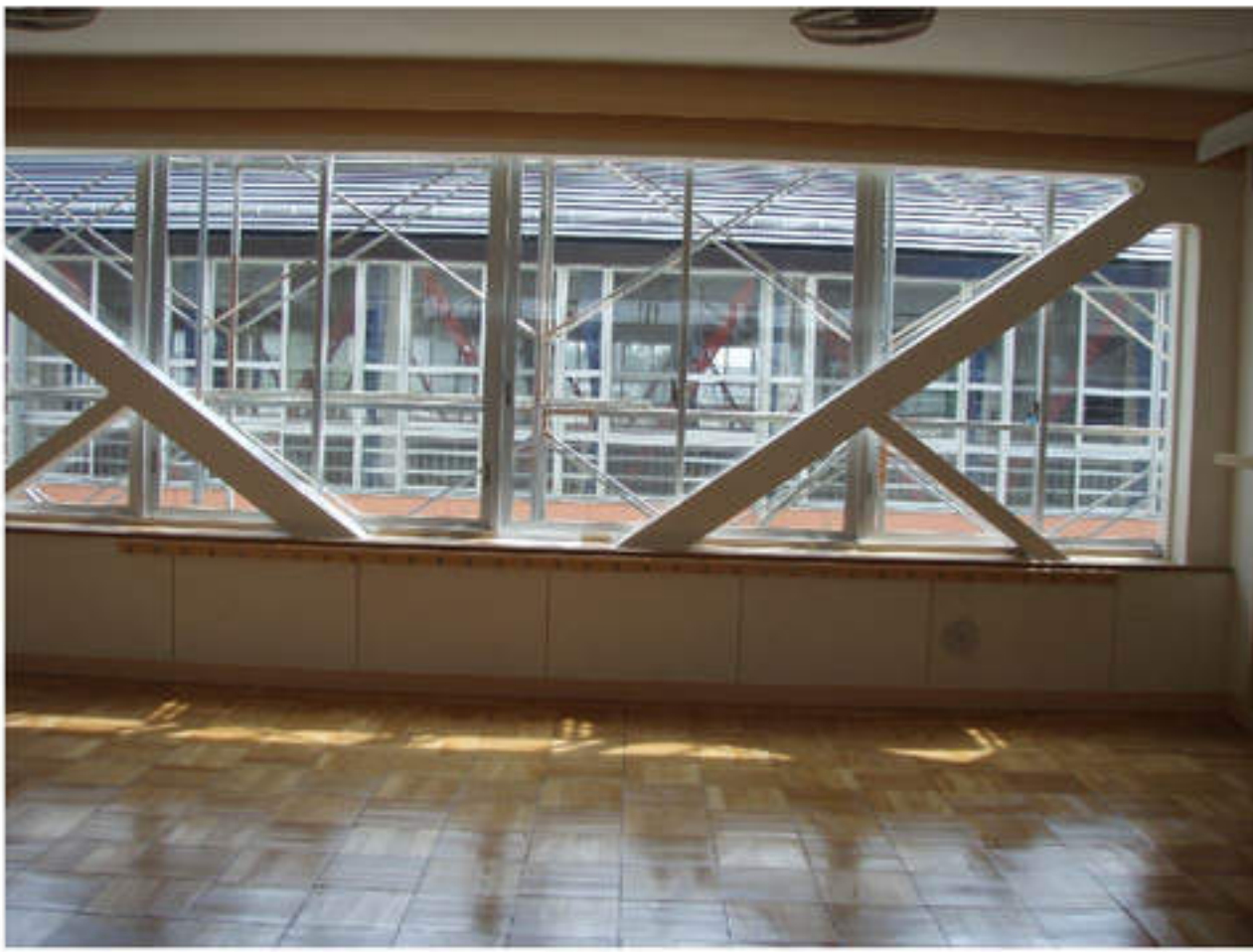
⑬北校舎東棟改修後 2階ブレース
