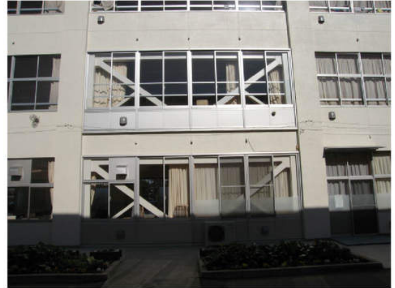
⑯北校舎東棟改修後 ブレース外観
