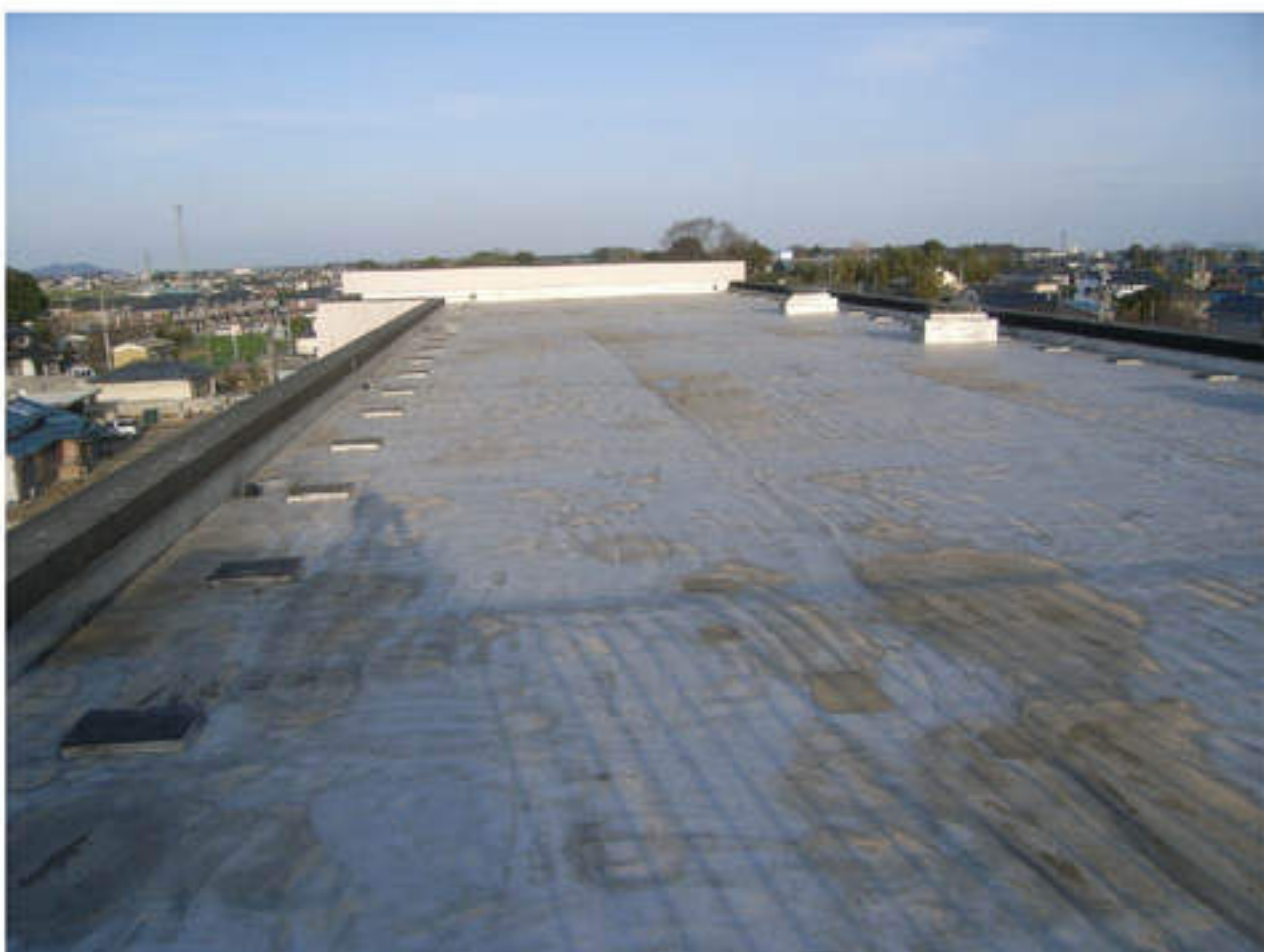
④北校舎東棟屋上改修前
