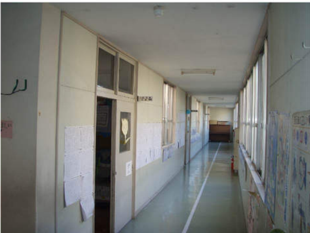
⑧南校舎廊下改修前
