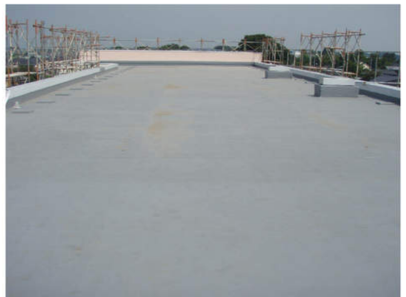
④北校舎東棟屋上改修後
