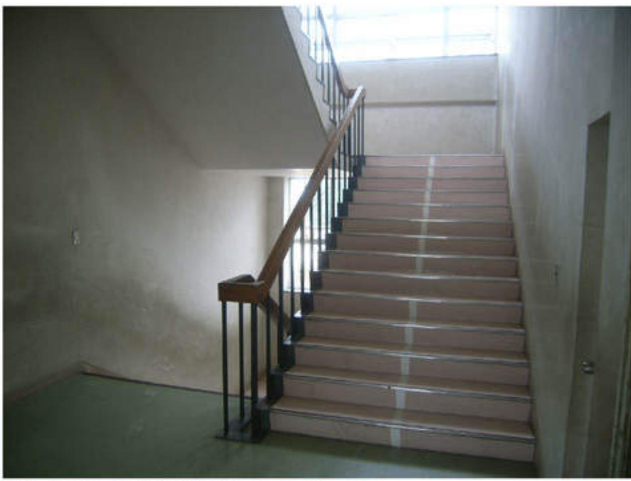
⑨北校舎東棟階段改修前
