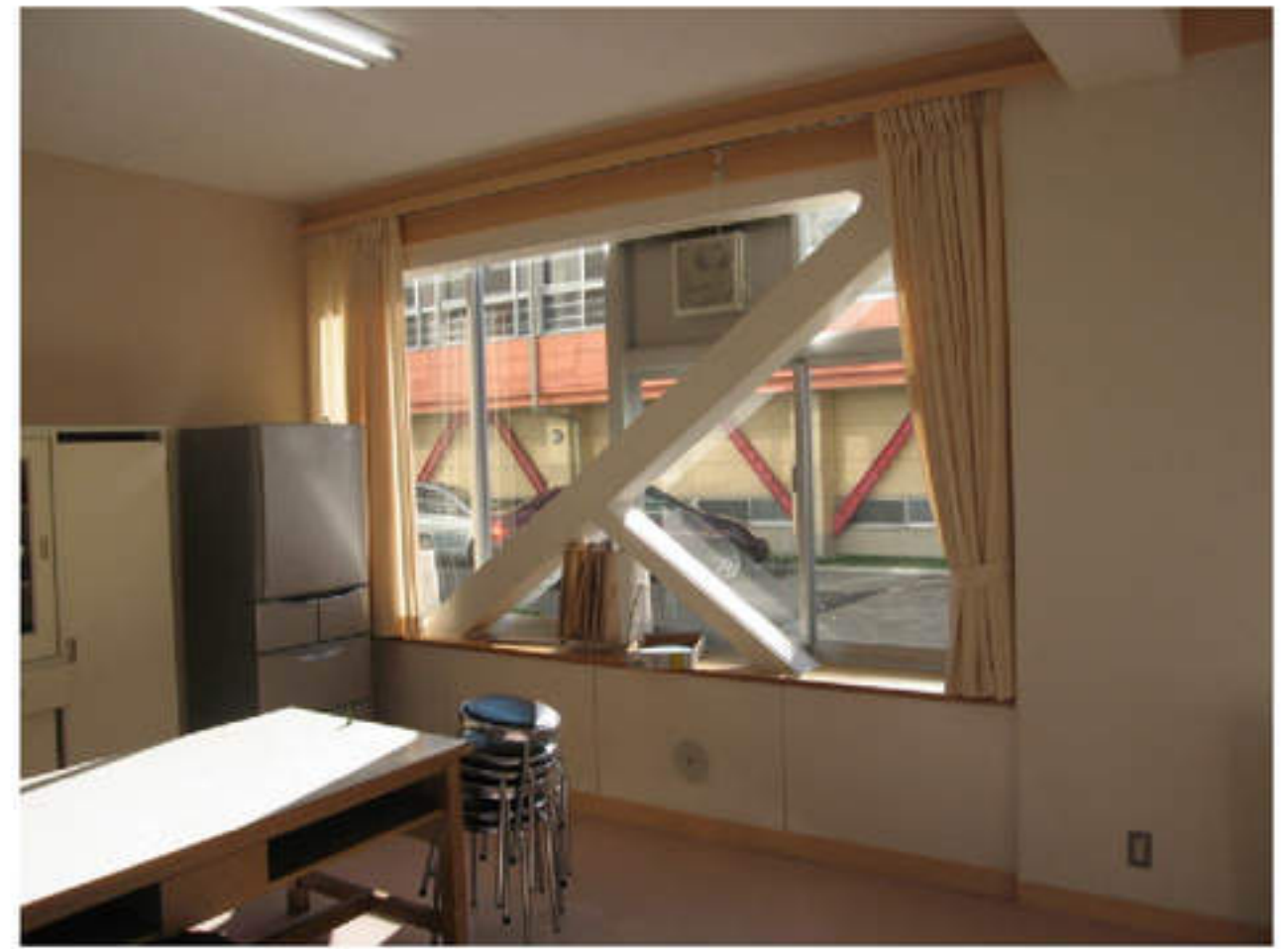
⑭北校舎東棟改修後 1階調理室内ブレース
