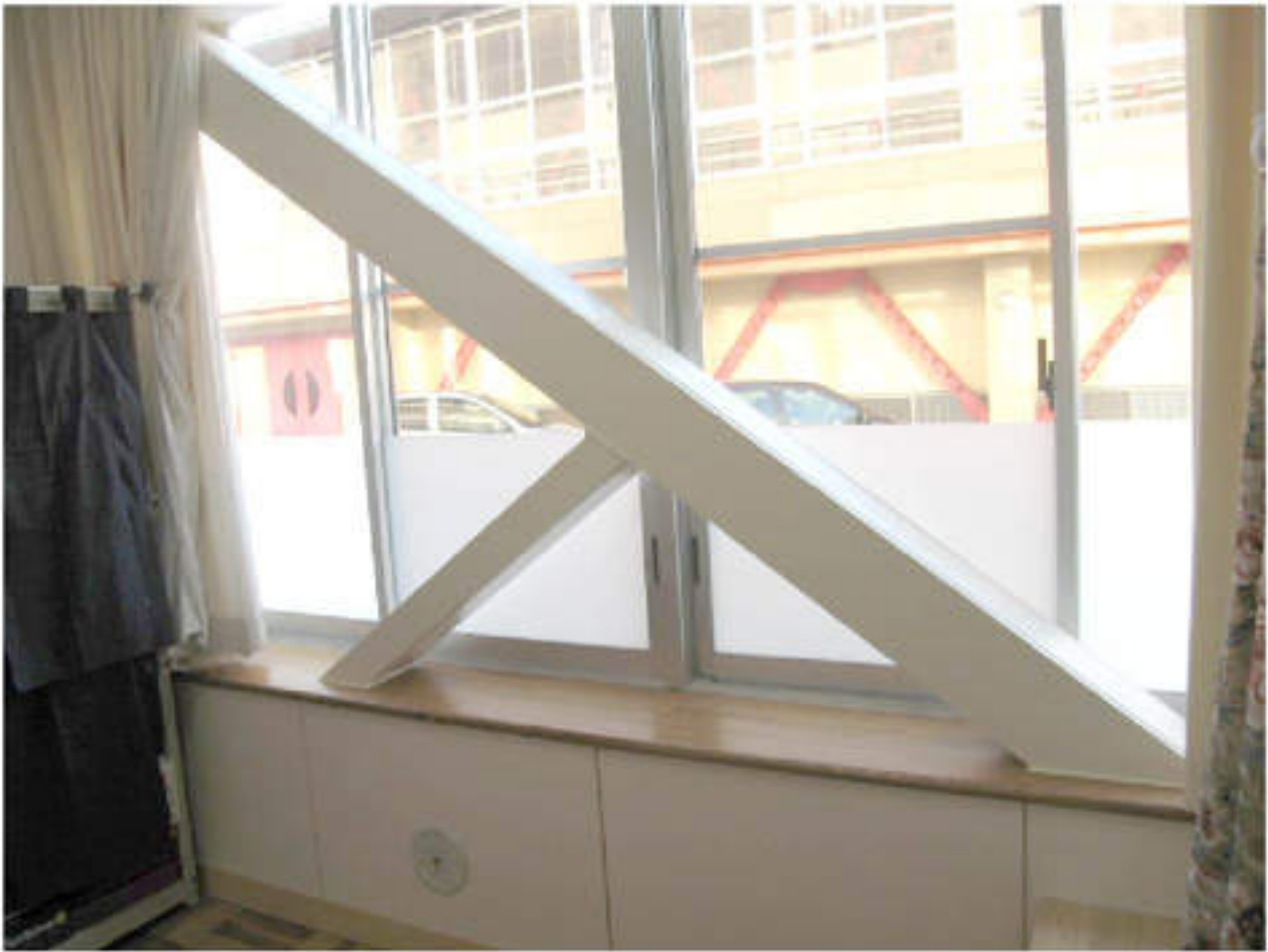
⑮北校舎東棟改修後 1階ことばの教室内ブレース
