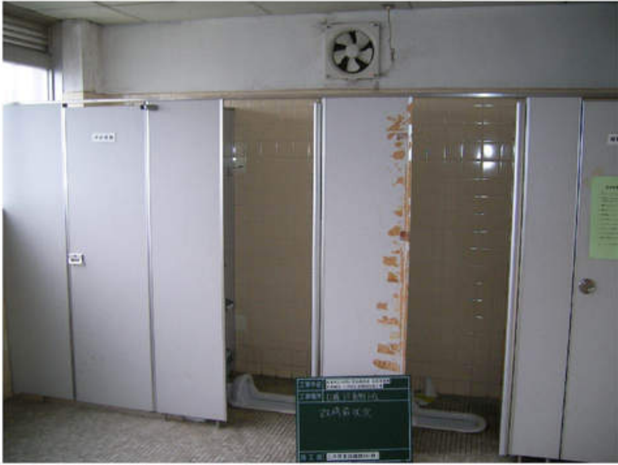
⑥北校舎東棟トイレ改修前
