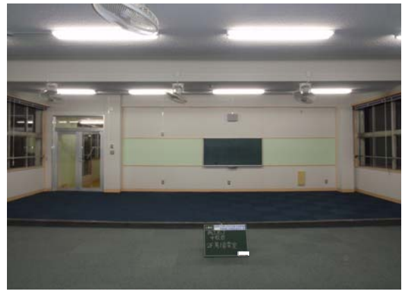
⑩改修後 2階音樂室東側
