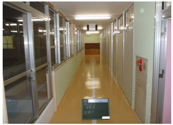
⑨改修後 2階廊下
