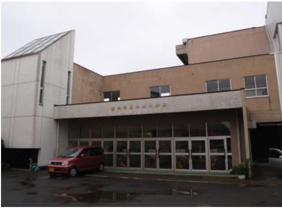
②改修前 校舎外観(東面)
