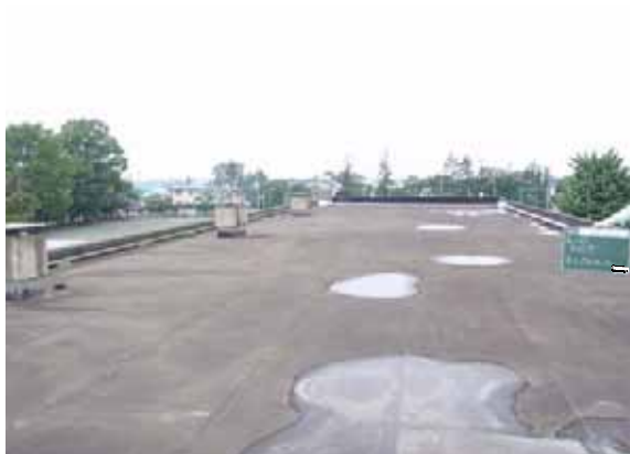
④改修前 屋上
