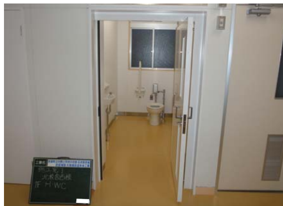
④改修後 多目的トイレ 改修により女子トイレ⇒多目的トイレ
