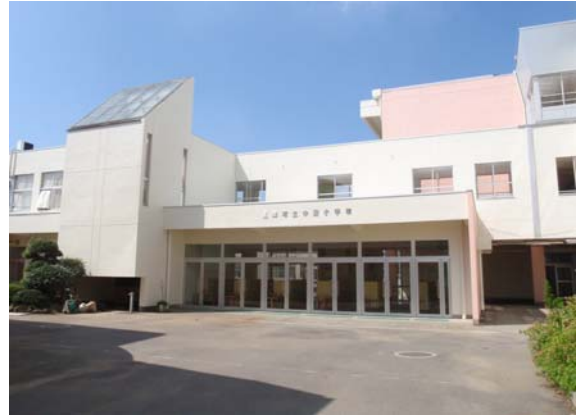
②改修後 校舎外観(東面)
