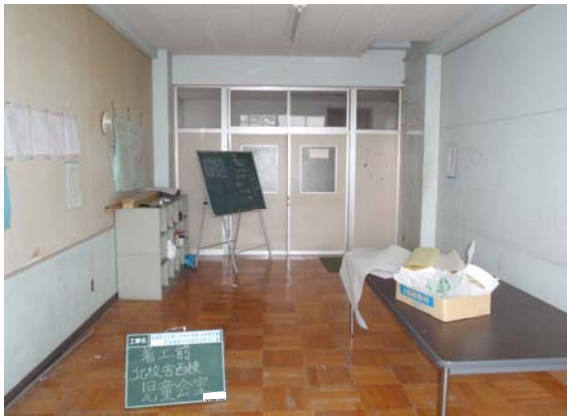
⑪改修前 3階児童会室
