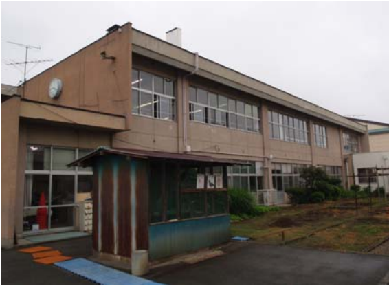
①改修前 校舎外観(南面)
