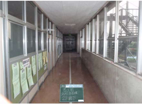
⑧改修前 2階廊下
