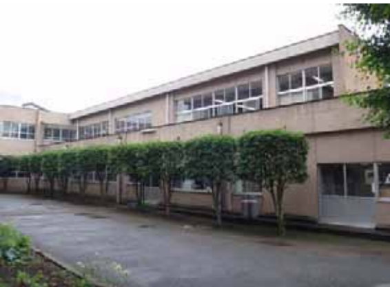
③改修前 校舎外観(北面)
