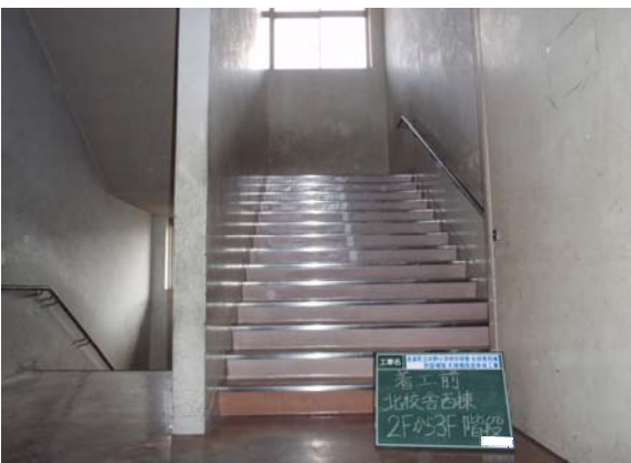
⑨改修前 階段(2階から3階)
