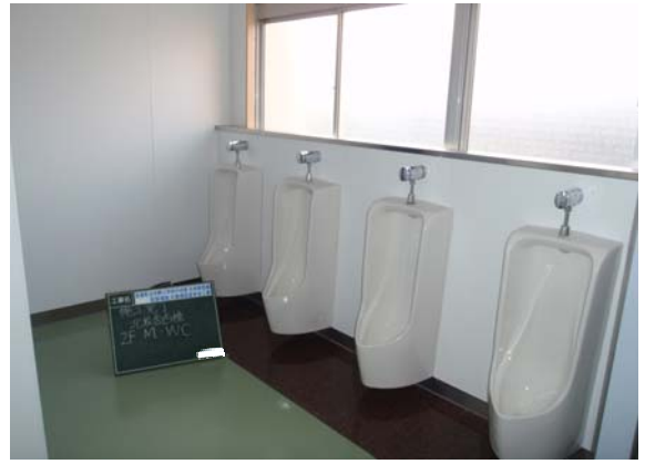
⑦改修後 2階男子便所
