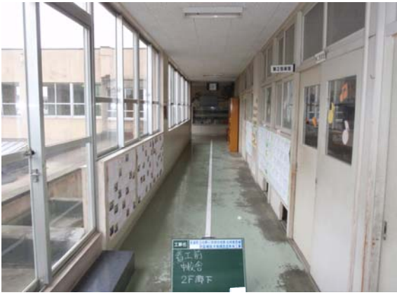
⑨改修前 2階廊下
