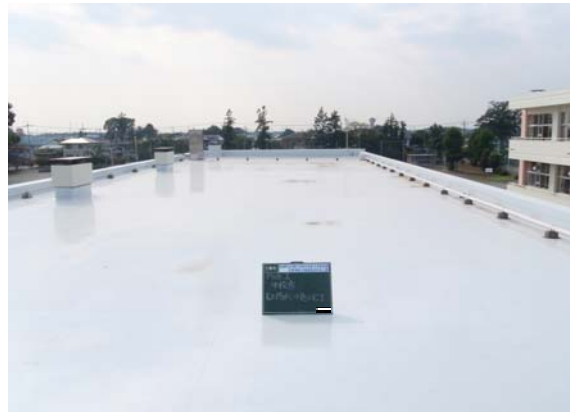
④改修後 屋上
