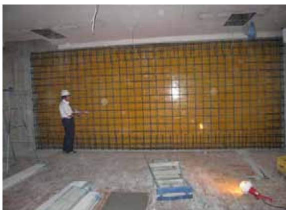
⑤補強箇所 施工中写真
