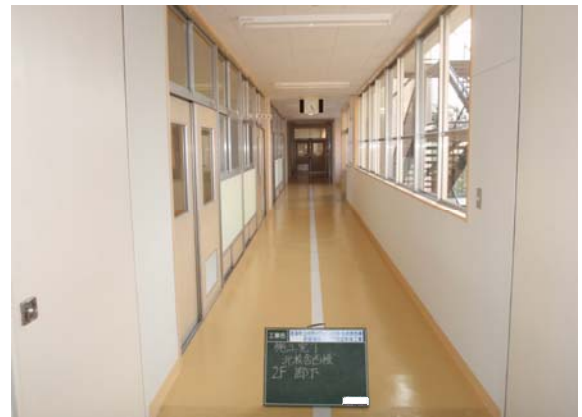
⑧改修後 2階廊下
