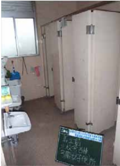
⑩改修前 3階女子トイレ
