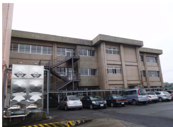
②改修前 校舎外観(北面)
