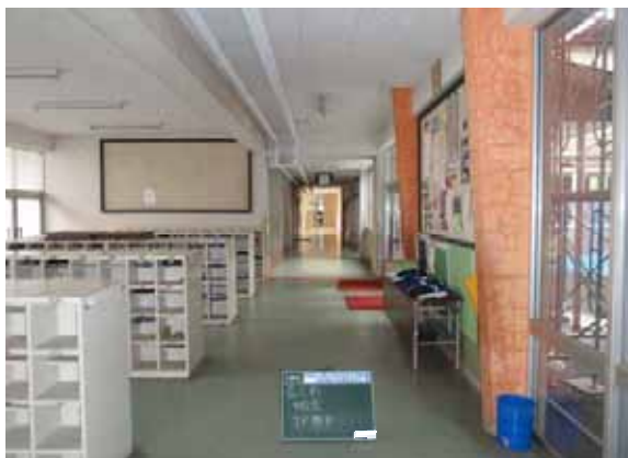
⑥改修前 生徒用昇降口西側通路
