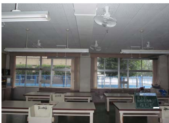
⑥改修前 1階被服室南側
