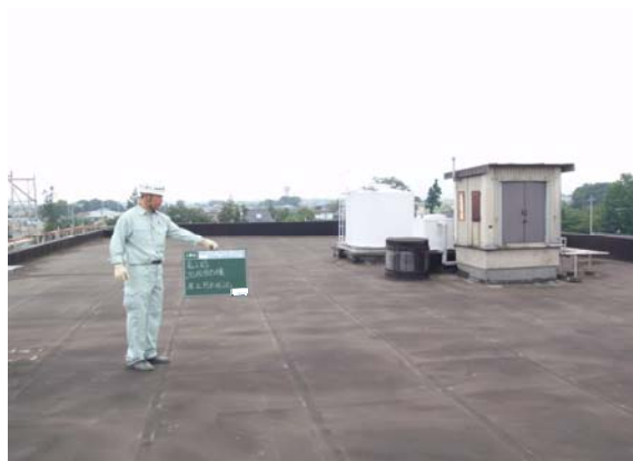
③改修前 屋上
