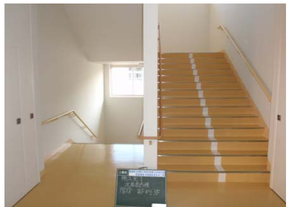
⑨改修後 階段(2階から3階)
