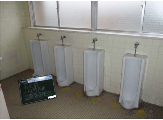
⑦改修前 2階男子便所
