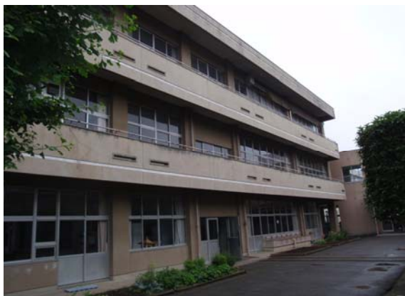
①改修前 校舎外観(南面)
