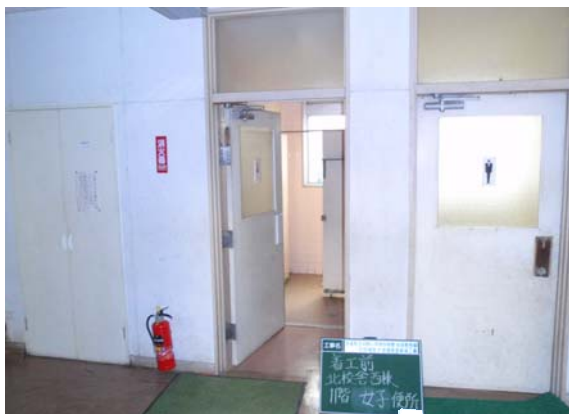
④改修前 女子トイレ
