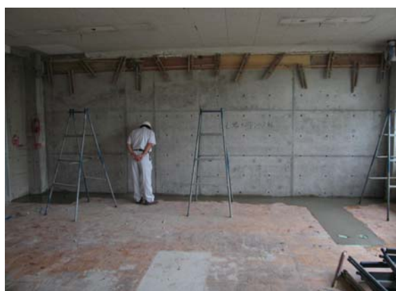
⑤補強箇所 施工中写真
