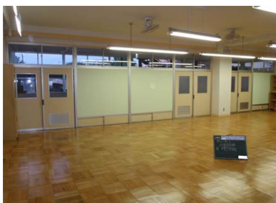
⑤改修前 1階特別支援教室北側
