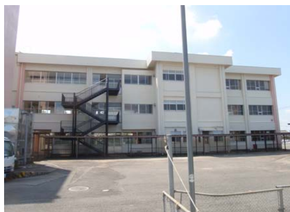
②改修後 校舎外観(北面)
