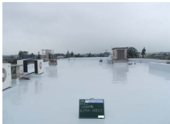
③改修後 屋上
