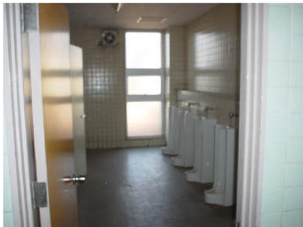
⑨ 1階 女子トイレ (旧男子トイレ) 改修前
