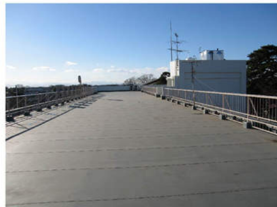
⑮屋上 改修後
