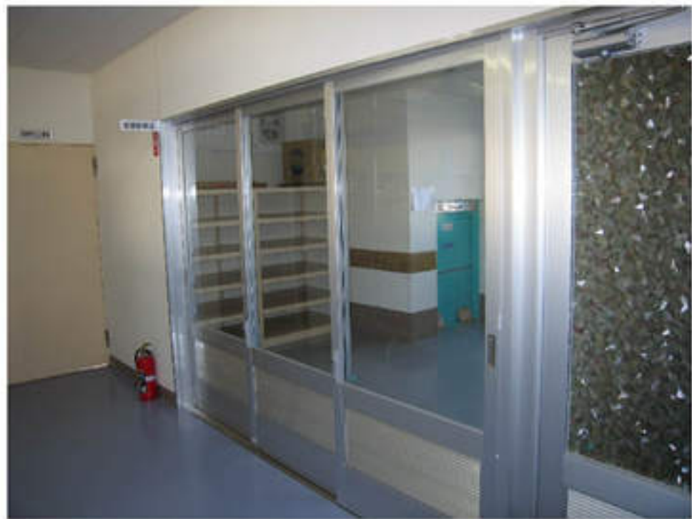
⑪ 2階 給食受入室改修後
