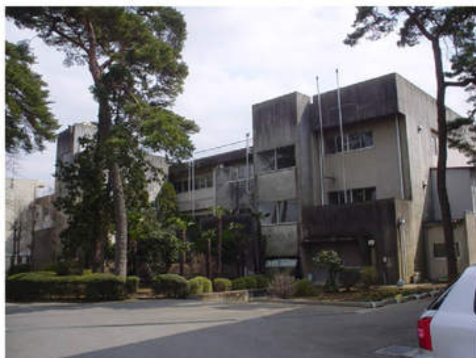
②校舎 改修前 北西より撮影
