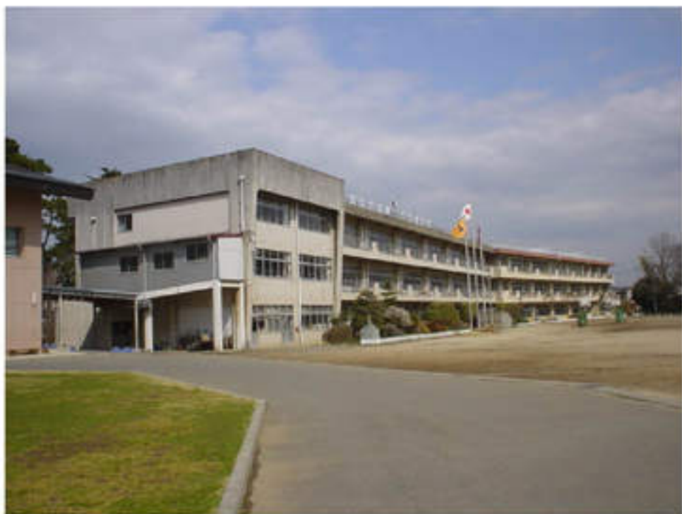
①校舎 改修前 南西より撮影
