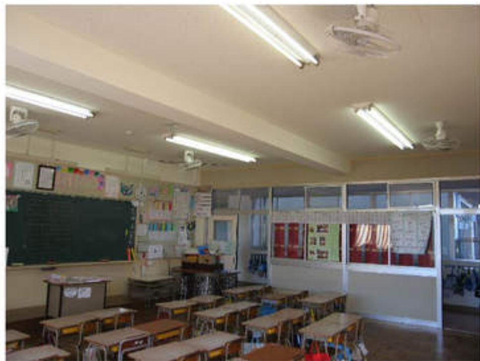
⑩ 1階 普通教室 (1-1) 改修後
