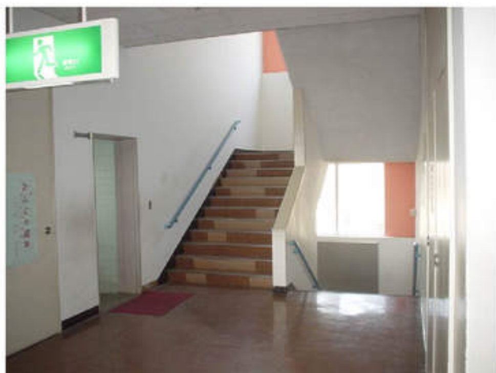
⑭ 3階 階段室改修前
