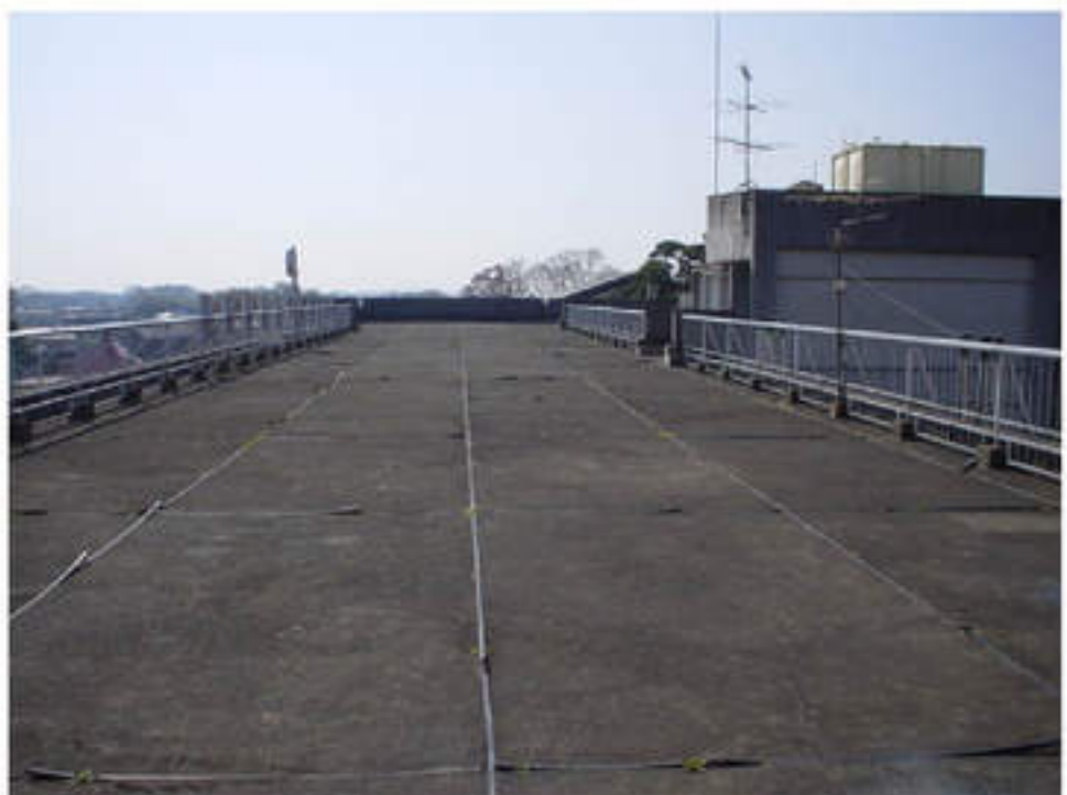
⑮屋上 改修前
