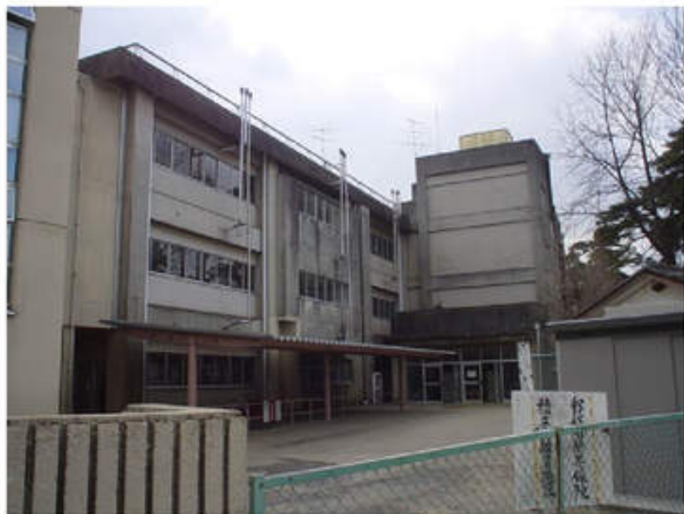
③校舎 改修前 北東より撮影
