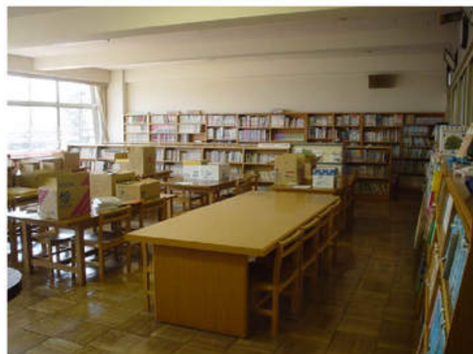
⑫ 2階 図書室改修前
