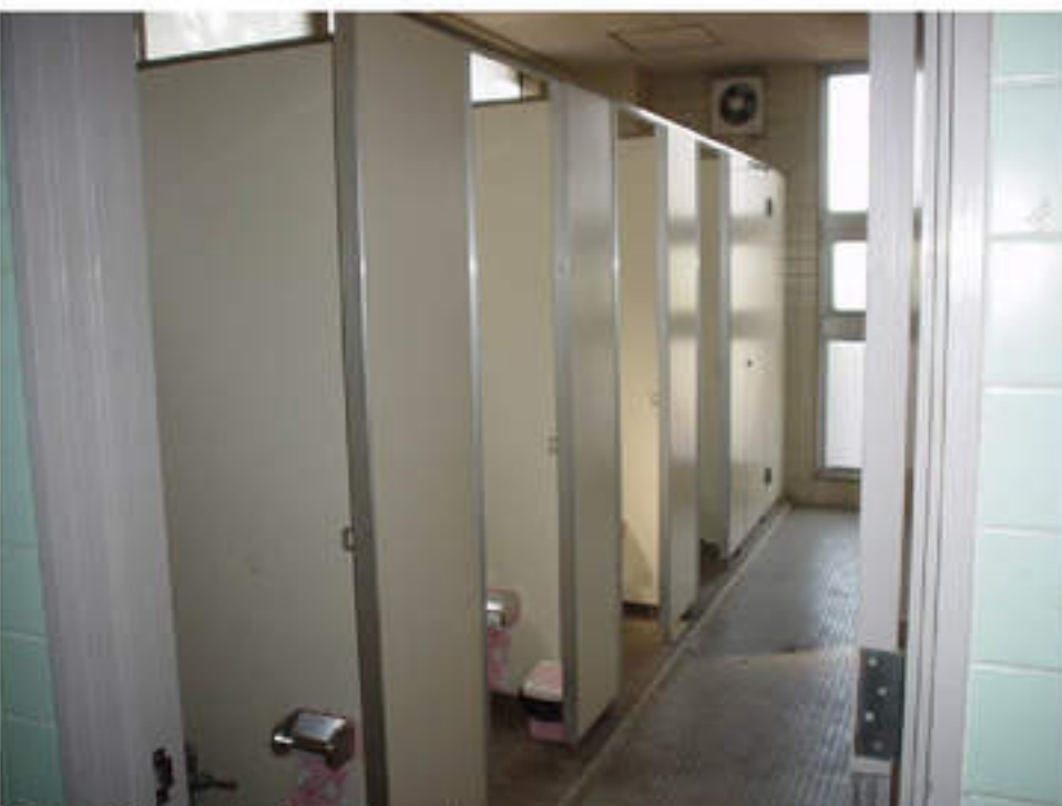
⑧1階 男子トイレ （旧女子トイレ）改修前
