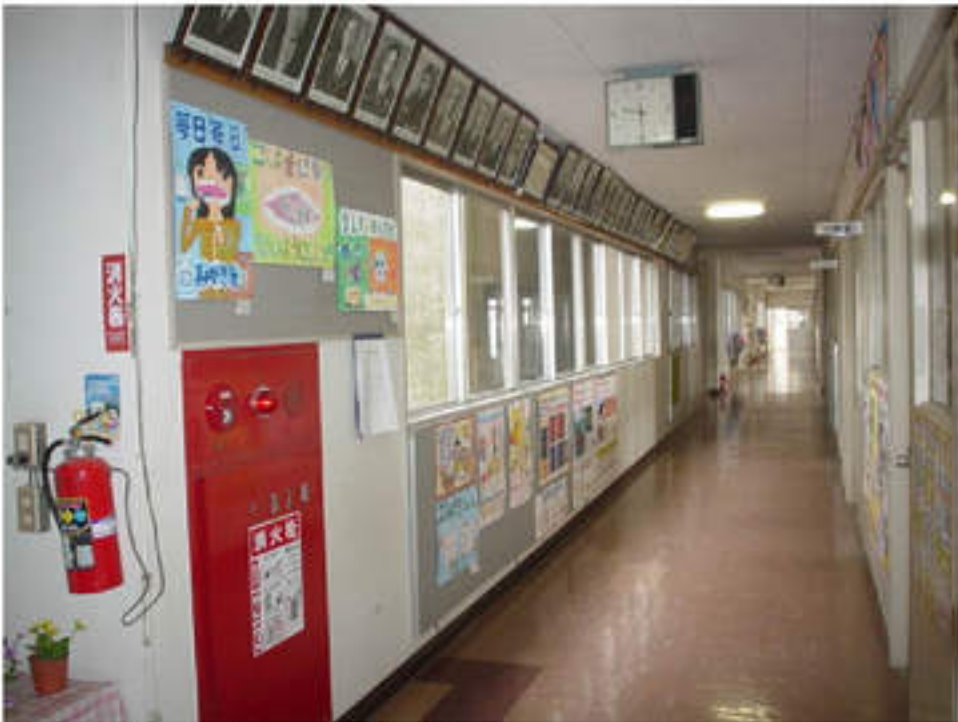
⑦1階 廊下改修前
