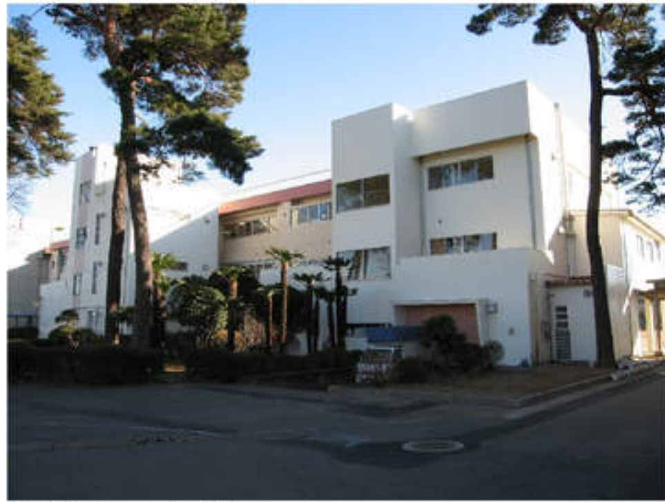
②校舎 改修後 北西より撮影
