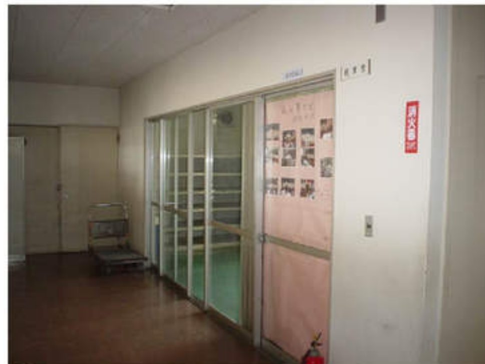
⑪ 2階 給食受入室改修前
