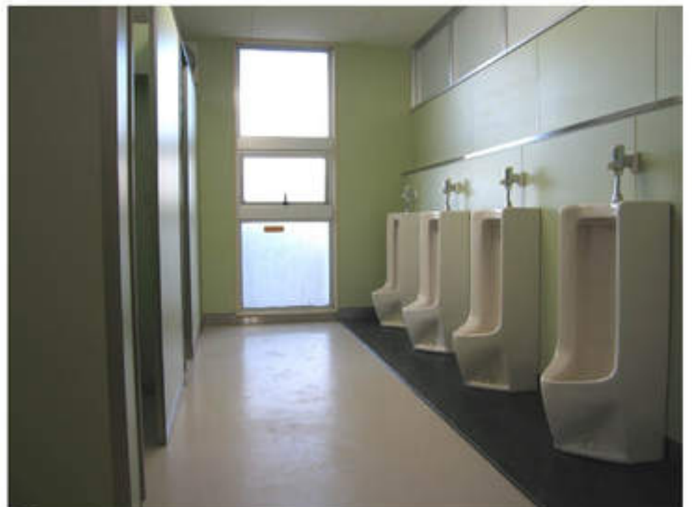
⑧1階 男子トイレ （旧女子トイレ）改修後
