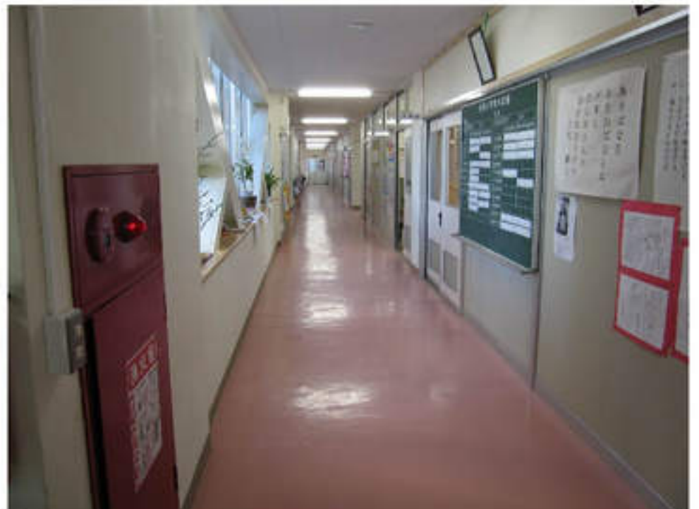
⑦1階 廊下改修後
