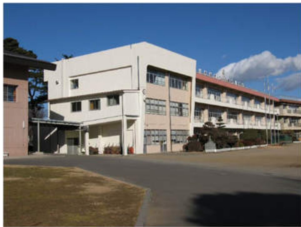
①校舎 改修後 南西より撮影
