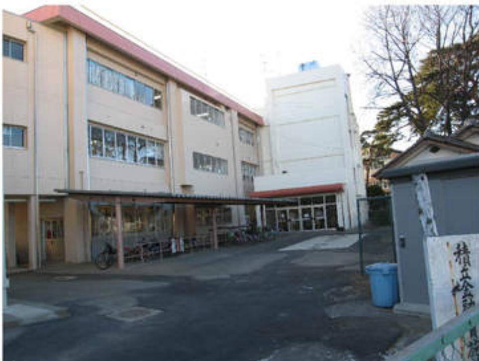
③校舎 改修後 北東より撮影
