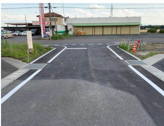
国道 122 号・区画道路 6-32 号線接続工事 (裏面⑥)
