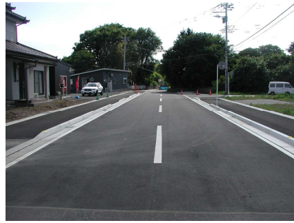
鶺中央線 区画道路6-8号線築造工事（裏面①）
