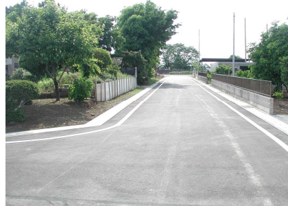
区画道路6-7-4-1号線築造工事（裏面③）
