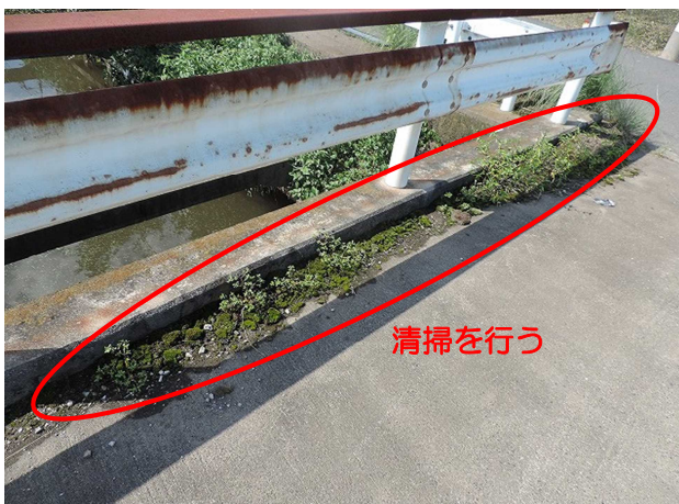
橋面土砂堆積の清掃
