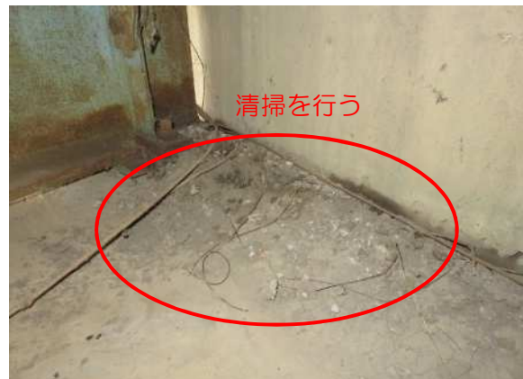
写真2 沓座土砂堆積
