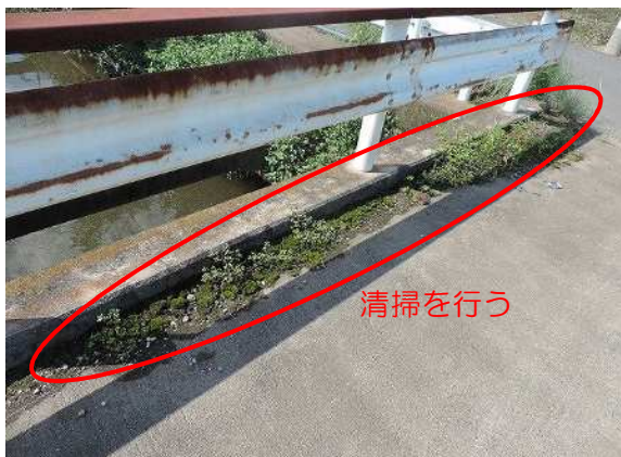
写真1 橋面土砂堆積
