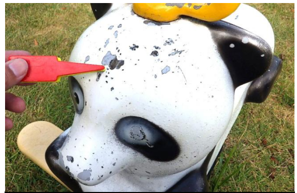
あけの公園（スプリング遊具の劣化）
