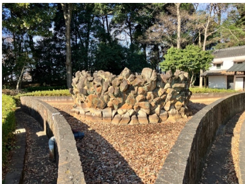
多々良沼公園（故障による休止中の噴水）
