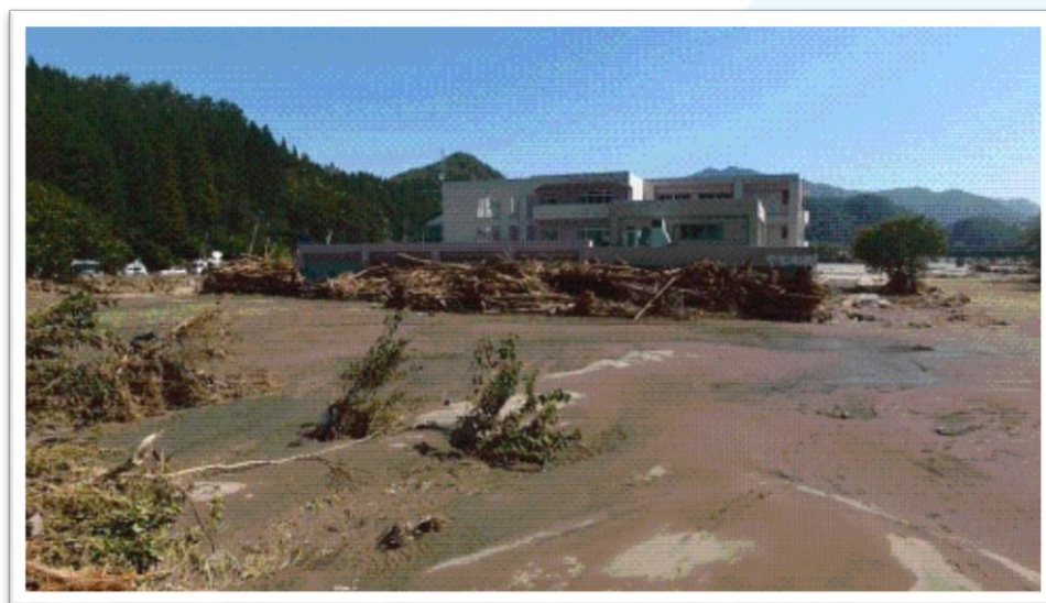
平成28年台風第10号による被害状況
