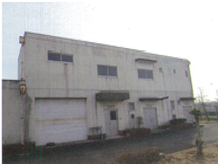
明野浄化センター
