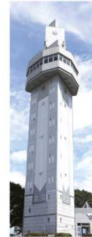
シンボルタワー
