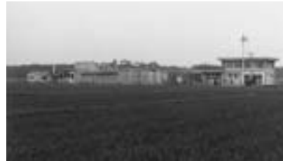
12 第三浄水場完成【昭和49年9月】
