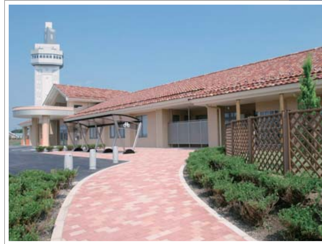
12 邑楽町保健センター完成 [平成18年8月] シンボルタワー東側に完成した保健センター。オープン記念講演会ではエッセイストの鈴木ひとみさんが講演しました。
