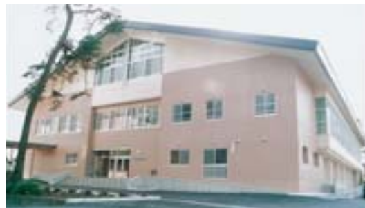
27 長柄小学校屋内運動場完成 [平成9年12月]
