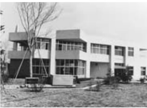
18 町立集会所完成 【昭和50年3月】
