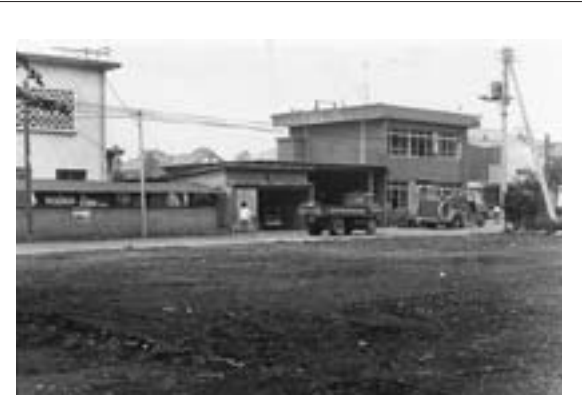
7 館林地区消防組合邑楽分署庁舎完成 【昭和46年2月】
