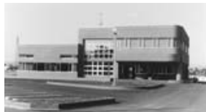
17 共同福祉施設完成【昭和60年3月】
