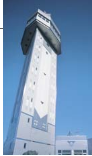
15 完成したシンボルタワー「未来MIRAI」 [平成5年5月]
