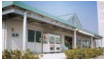
20 あいあいセンター完成 [平成8年3月]
