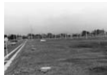
10 中野住宅団地造成工事完成 【昭和48年3月】
