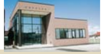
9 商工会館完成【平成2年3月】
