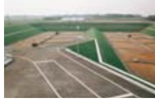
22 一般廃棄物最終処分場完成 [平成9年5月]
