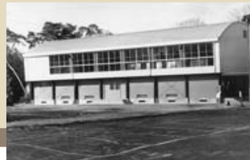
6 長柄小学校屋内運動場完成 【昭和45年11月】 高島小学校と同時に長柄小学校の屋内運動場も、広さ504㎡、総工費1,620万円で作られました。
