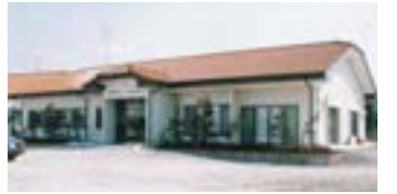
19 福祉作業所完成 [平成7年3月]
