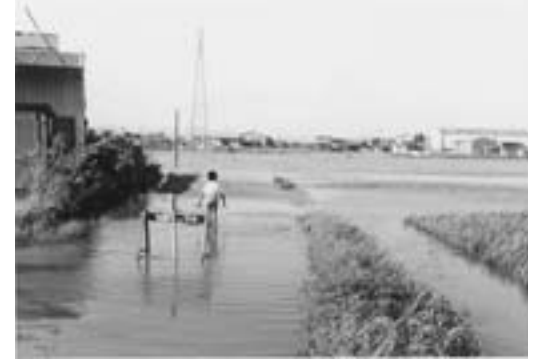
10 台風18号による被害【昭和57年9月】
