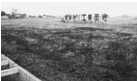
4 造成工事完了の鞍掛工業団地 [昭和54年9月]
