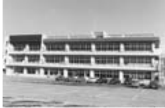
16 高島小学校増改築工事完成 【昭和51年12月】
