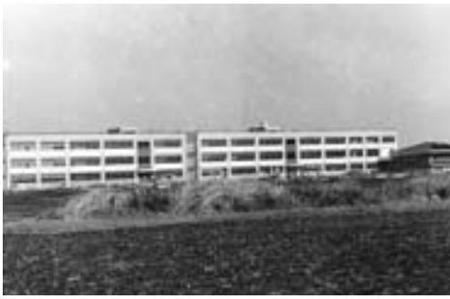
3 完成間近の邑楽中学校 【昭和44年2月】 統合「邑楽中学校」の発足（昭和44年4月1日）に向けて、42年から校舎の建設工事が進められていました。
