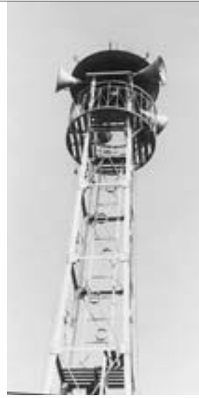
8 火の見やぐらに設置された屋外有線放送のスピーカー 【昭和47年3月】
