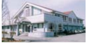
14 勤労者体育センター完成 [平成4年3月]
