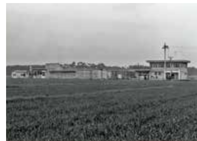
11 第三浄水場完成 〔昭和49年9月〕
