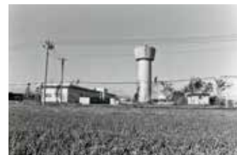
15 中野浄水場完成 [昭和59年 3月]
