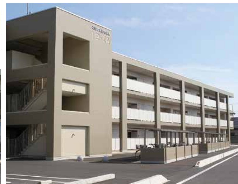
5 石打町営住宅A棟完成 [平成24年3月] RC造3階建て(24戸)翌年にはB棟(23戸)も完成。
