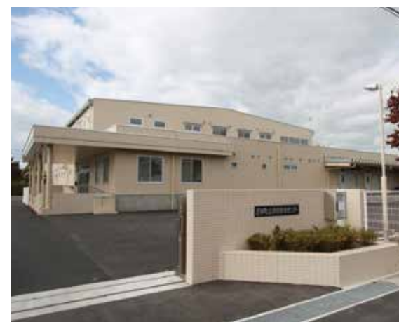
3 学校給食センター新築移転 [平成23年8月]
