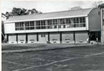
6長柄小学校屋内運動場完成【昭和45年11月】
