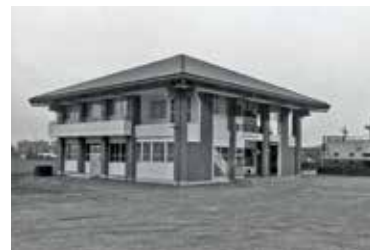
7 武道館完成 [昭和55年3月]
