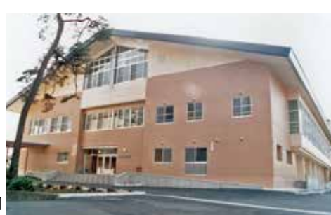
27長柄小学校屋内運動場完成 〔平成9年12月〕
