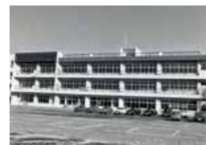
15 高島小学校増改築工事完成 〔昭和51年12月〕
