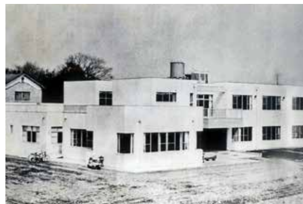
10 邑楽町公民館社会福祉センター完成 〔昭和48年3月〕
