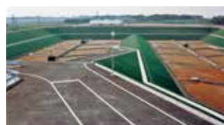
22一般廃棄物最終処分場完成 〔平成9年5月〕
