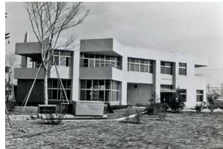
12 町立集会所完成 〔昭和50年3月〕 新中野住宅団地に、大会議室、レクリエーション室、談話室などを備えた2階建の集会所ができました。
