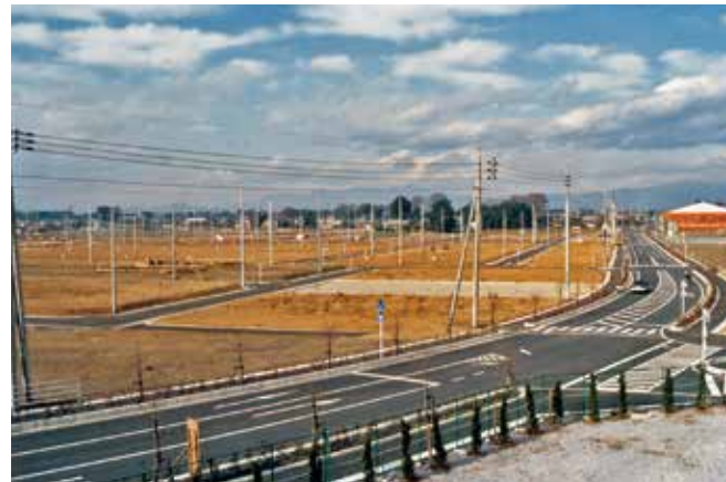
21 完成した明野団地 [昭和62年 8月] 中野第二住宅団地の大字が新しく「明野」となりました。
