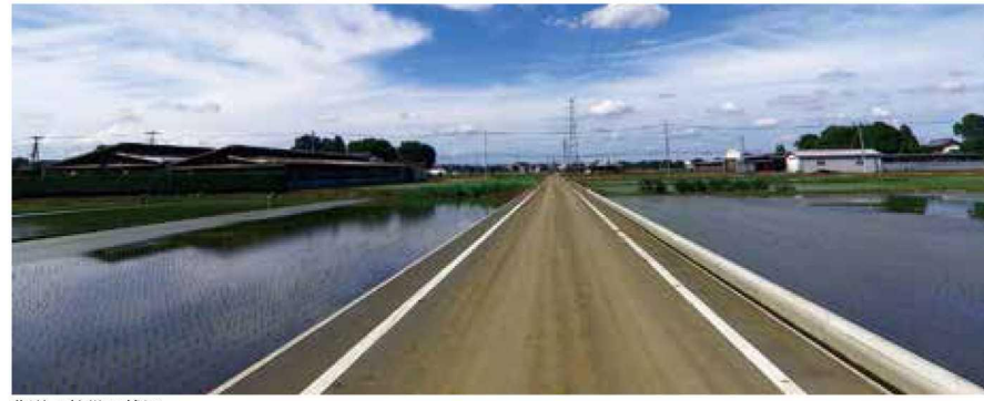
農道の整備の状況
