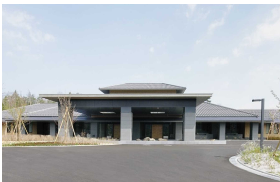
写真1 大屋根方式とした車寄せ（三次市斎場）
