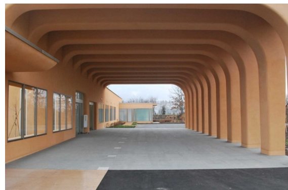
写真2 段差が無くフラット化された床（音更町火葬場）
