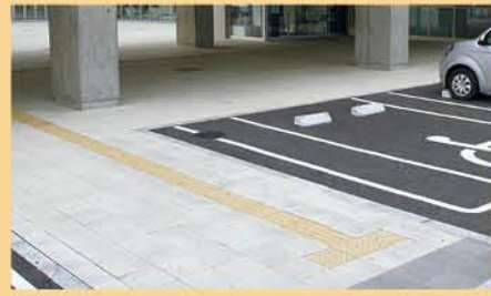
【点字ブロック】（写真は中央公民館）
