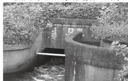
制水樋門取水口「大樋」、ここから逆川に放流
