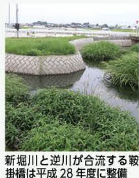
新堀川と逆川が合流する観音橋は平成28年度に整備
