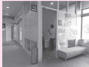
町役場庁舎1階にある喫煙スペース。ドアで空間を仕切ることができるが、ドアを開けるとたばこの臭いが庁舎内に流れ込んでくる
