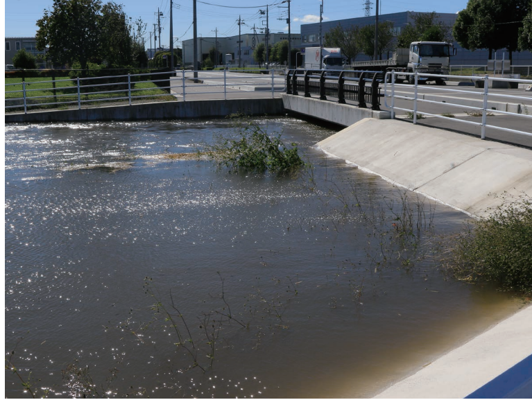
新堀川は台風などによる豪雨時に、たびたび越水したため、現在の形へ改修されてきました(写真は昨年10月の台風の後、鞍掛橋付近)
