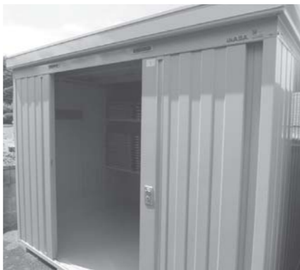
備品を収納するために設置された物置
