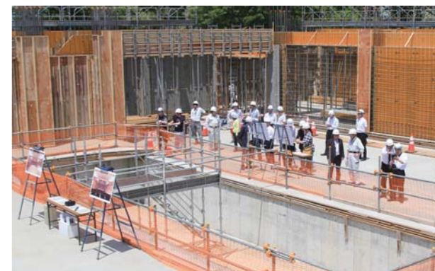
コンクリートの基礎打ちが終わり、壁も立ち始めた木のホール。建物の形、大きさ、広さ、高さを体感することができました
