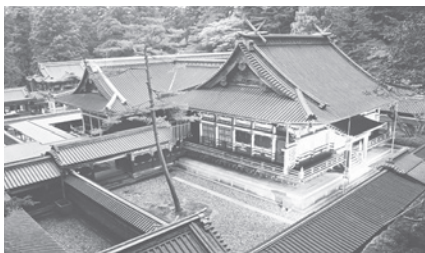
修理前：北側背後から本殿・石の間・拝殿・陽明門を見通した全景
