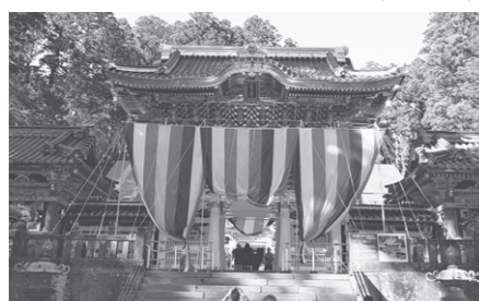
五色の幕が垂らされ、竣工式を待つばかりの陽明門
