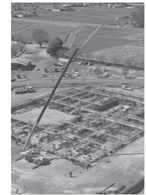
着々と工事が進む中央公民館
