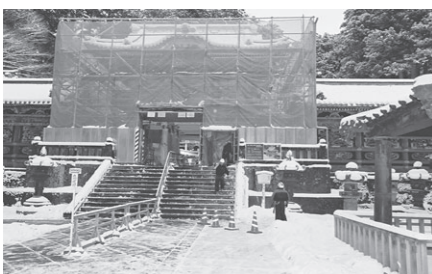
雪とシートのベールに包まれ竣工式を待つ陽明門
