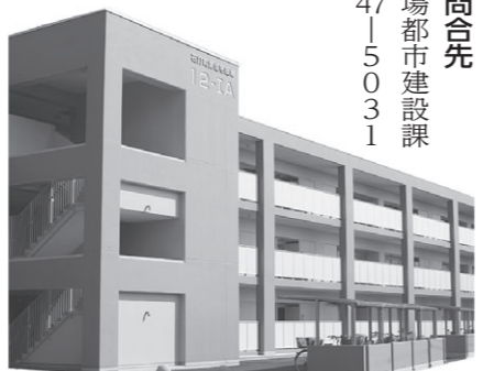
写真は、石打地内にある石打町営住宅
